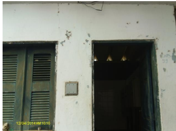
Foto 3 – Casa de bombas EEAT-01 sem identificação.
