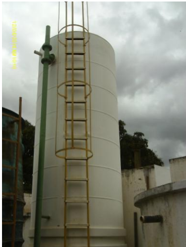
Foto 6 – Decantador sem identificação.
