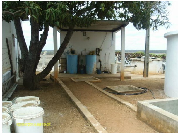
Foto 9 – Ausência de identificação na área da ETA.
