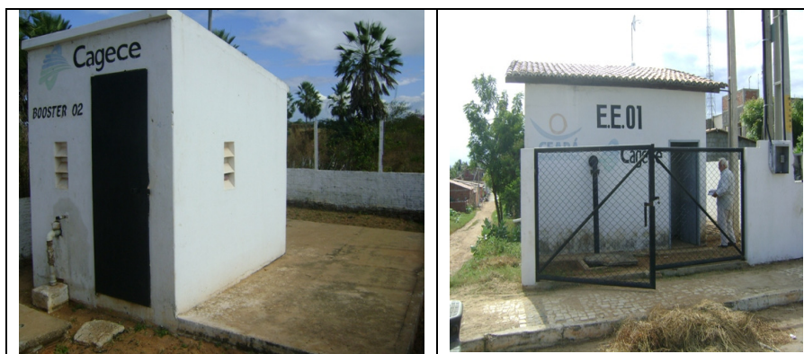
Fotos 31 e 32 – Casas de proteção do Booster-02 e EE-01
