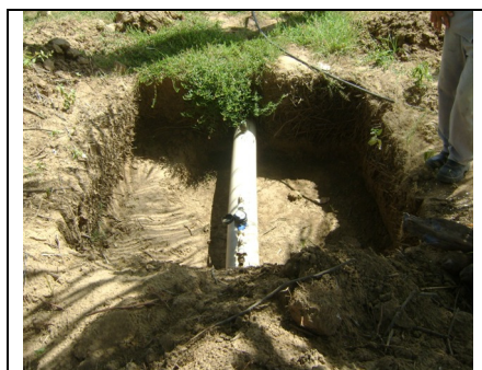
Foto 44 – Macromedidor na entrada da ETA.
