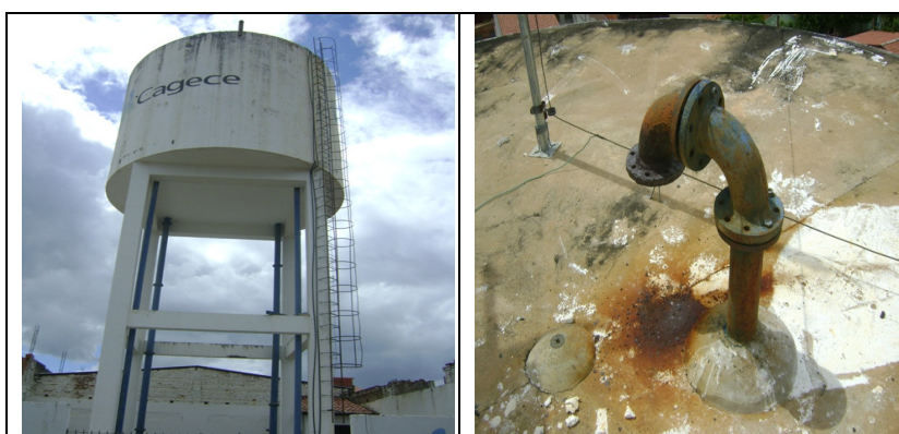
Foto 38 – Vista do REL-01.
