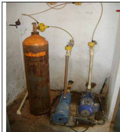
Foto 15 – Cilindros de cloro.
