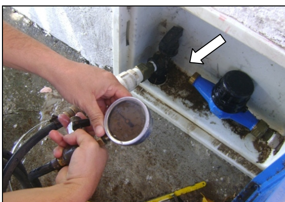
Foto 92 – Medição de pressão, sem hidrômetro, na Rua Vicente Siebra, 2.692 - Violete.
