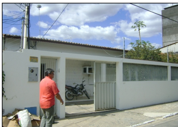
Foto 97 – Vista externa do escritório operacional da CAGECE.
