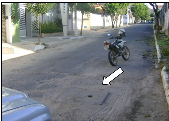
Foto 78 – Registro de descarga na Rua Frei Cassiano, Centro.
