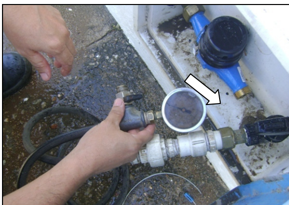
Foto 90 – Medição de pressão, sem hidrômetro, na Rua Pedro I, 268 - Boa Vista.
