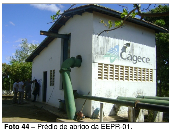
Foto 44 – Prédio de abrigo da EEPR-01.
