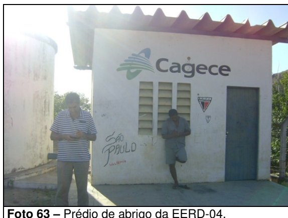
Foto 63 – Prédio de abrigo da EERD-04.
