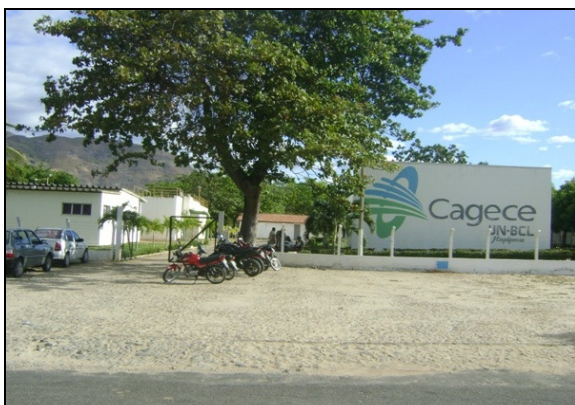
Foto 18 – Vista da ETA-02.
