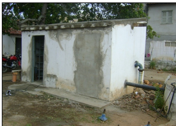
Foto 61 – Prédio de abrigo da EERD-02.
