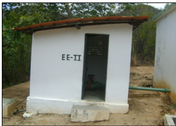
Foto 54 – Prédio de abrigo da EEAT-02.
