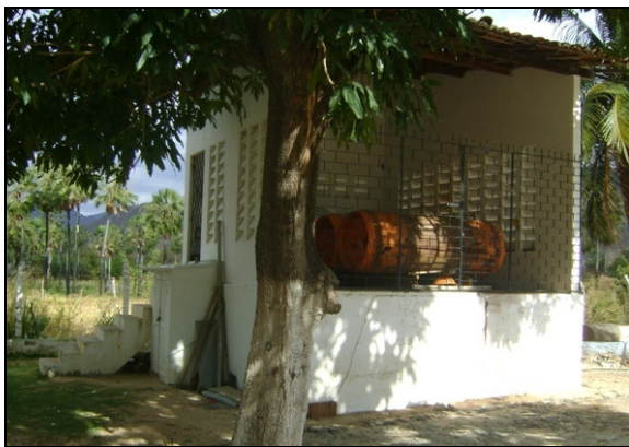
Foto 29 – Casa de cloro.
