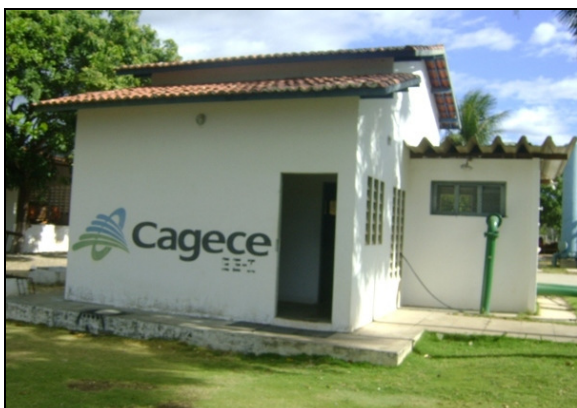
Foto 57 – Prédio de abrigo da EEAT-03.
