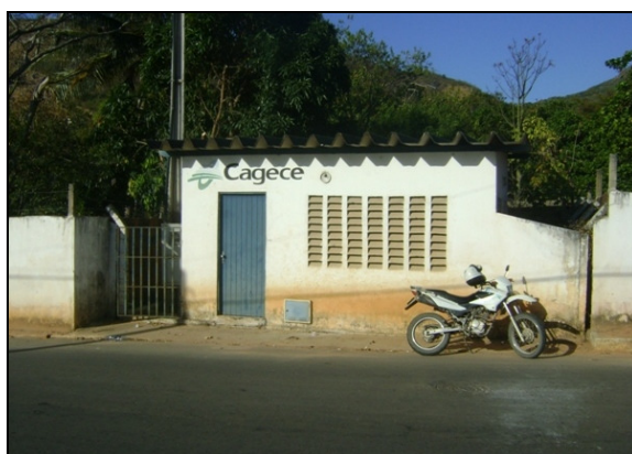
Foto 62 – Prédio de abrigo da EERD-03.
