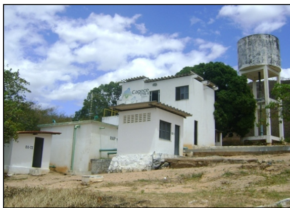
Fotos 4 – Vista da ETA-01.
