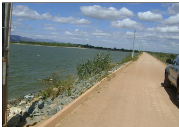
Foto 2 – Tomada d'água do Açude Poço Verde.
