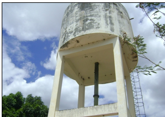
Foto 74 – Vista do REL-01.
