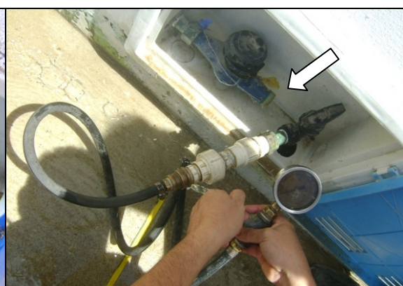
Foto 93 – Medição de pressão, sem hidrômetro, na Rua Sebastião Rodrigues Teixeira, 1.125 - Parque de Exposição.
