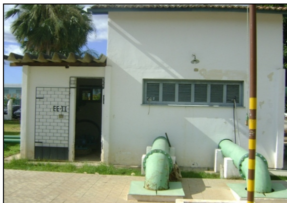
Foto 47 – Prédio de abrigo do quadro da EEAB-01.
