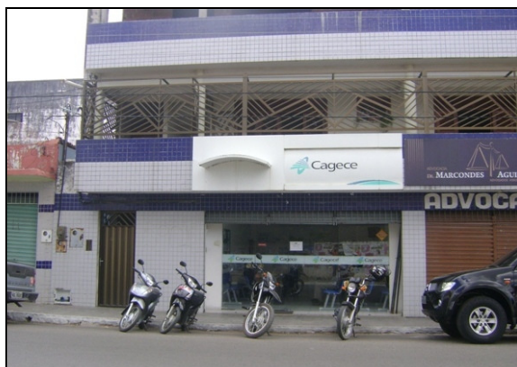
Foto 94 – Vista externa da loja de atendimento da CAGECE.
