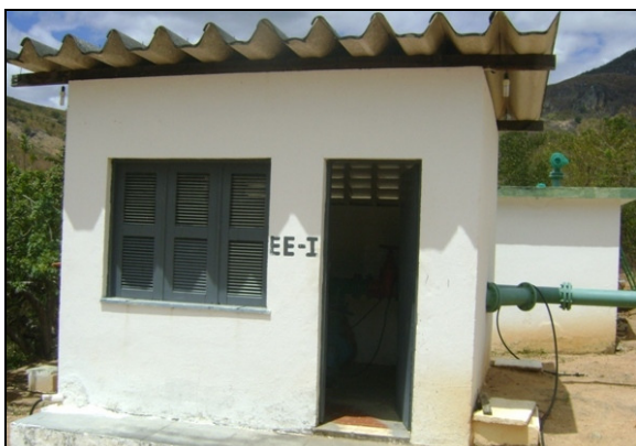
Foto 50 – Prédio de abrigo da EEAT-01.
