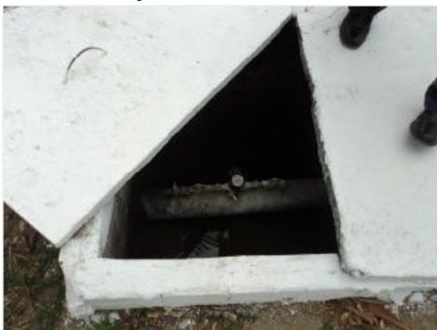
Foto 33 – AAB: medidor parado.
