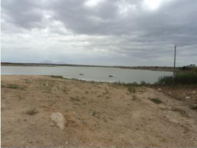
Foto 1 – Açude São Pedro da Timbaúba: ausência de identificação da área do manancial destinada ao abastecimento público e de cerca delimitadora.
