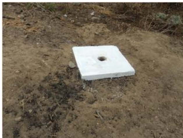
Foto 58 – Medição instantânea de pressão na Rua José teixeira – Campo Alegre.
