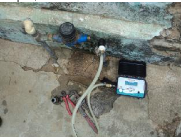
Foto 55 – Rede de distribuição: medição instantânea de pressão na Rua José Teixeira, 221 – Campo Alegre.
