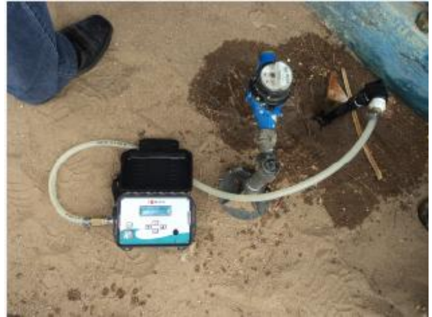
Foto 52 – Rede de distribuição: medição instantânea de pressão na Rua Valdevino Mendes, 995 (Escola Lindolfo Paula Braga).
