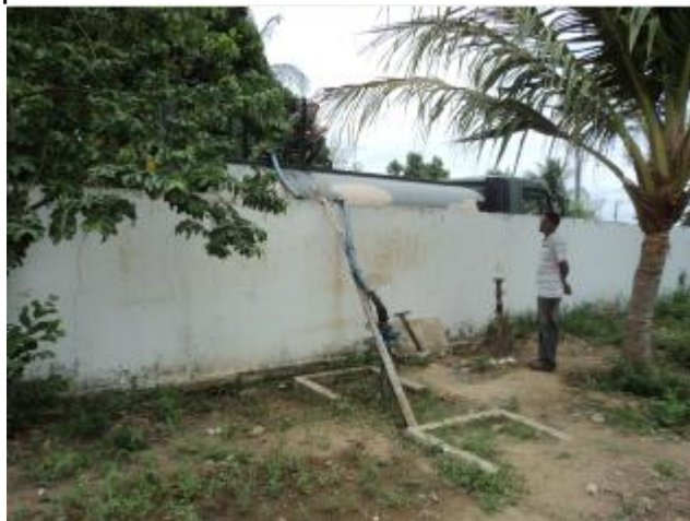
Foto 31 – ETA: abastecimento de carro-pipa.
