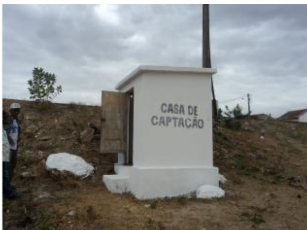
Foto 5 – EECS: casa de abrigo do quadro de comando.
