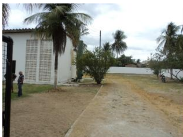
Foto 10 – ETA: condições de limpeza do pátio.
