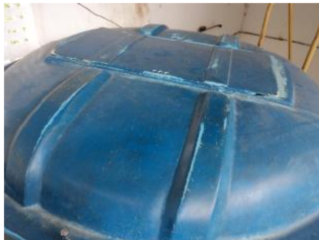
Foto 18 – Filtro F-2: tampa de inspeção.
