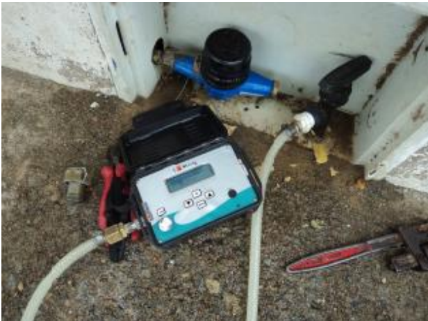
Foto 53 – Rede de distribuição: medição instantânea de pressão na Rua Francisco Marques, 973 - Centro.
