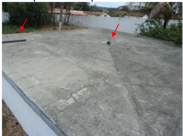
Foto 42 – RSE-02: cobertura do reservatório – tampa de inspeção e tubulação de ventilação.
