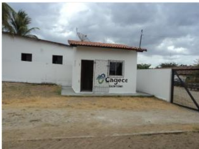
Foto 59 – Loja de atendimento: vista externa.
