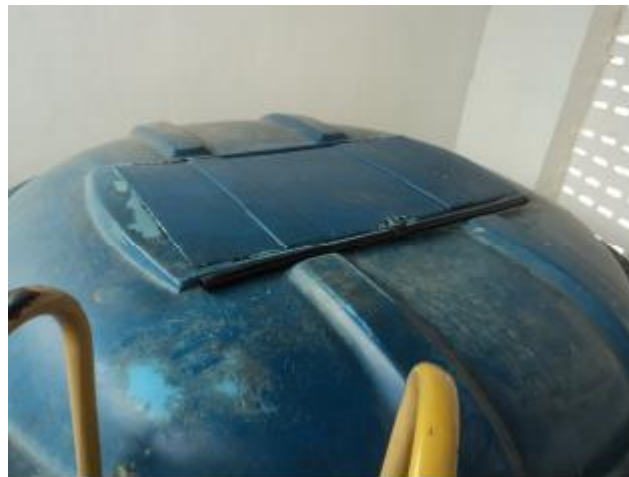
Foto 16 – Filtro F-1: tampa de inspeção.
