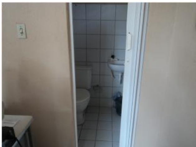
Foto 63 – Loja de atendimento: instalações sanitárias.
