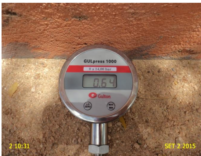
Foto 18 – Medição de pressão na Rua José Antônio de Melo, s/n – Vila Nova.
