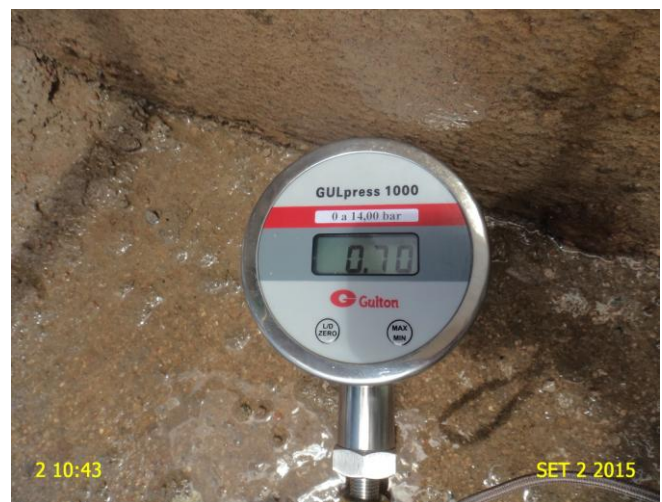
Foto 19 – Medição de pressão na Travessa São José (SMS – 25).
