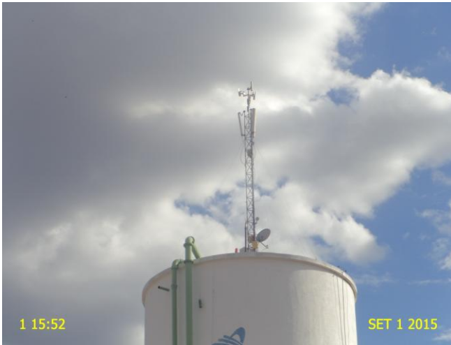
Foto 6 – REL-01: ausência de guarda-corpos na laje de cobertura.
