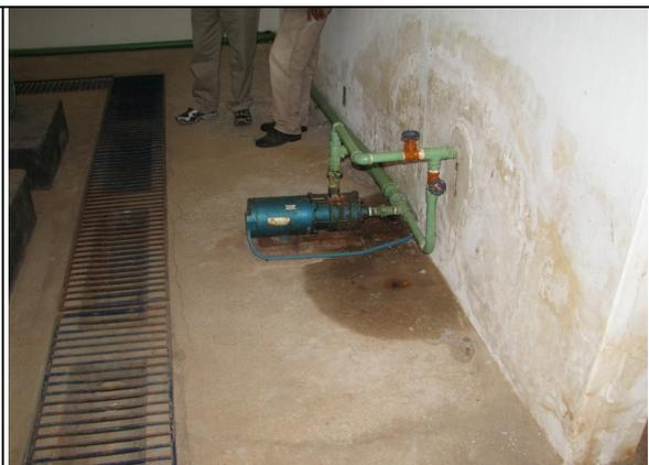
**Foto 33** – EELF-01 – booster de injeção de cloro para a torre de nível.
