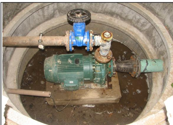
**Foto 26** – Elevatória Rio Acaraú – tubulação de recalque com pintura deteriorada.
