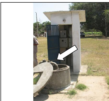
**Foto 28** – EEPT-05 – tubulação de sucção com pintura deteriorada.
