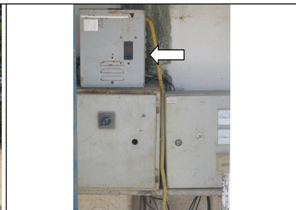
**Foto 25** – Elevatória Rio Acaraú – quadro de comando sem horímetro e pintura deteriorada.
