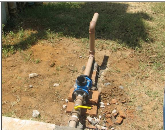
**Foto 39** – Tomada de água do carro pipa sem caixa de proteção.
