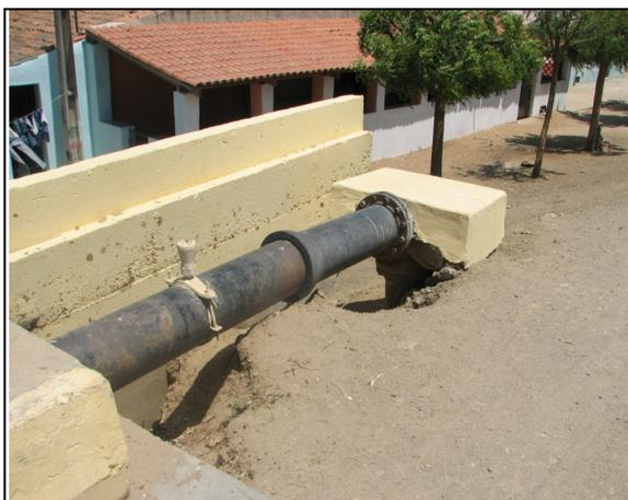
**Foto 42** – Ventosa na adutora de água tratada sem caixa de proteção.
