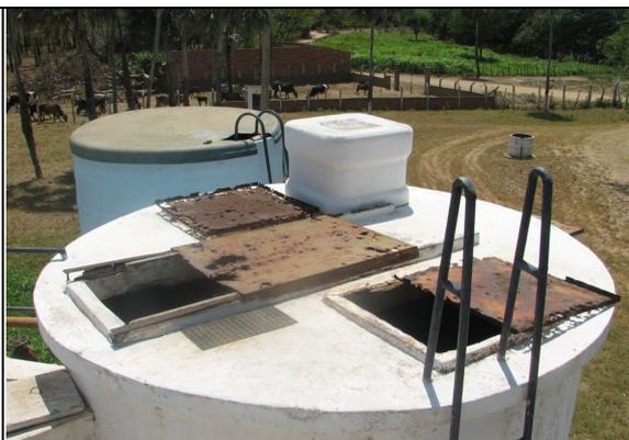
**Foto 10** – Filtro 2 – tampas deterioradas.
