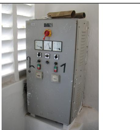
**Foto 31** – EEDR-01 – pintura deteriorada do quadro de comando.
