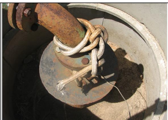
**Foto 29** – EEPT-06 – tubulação de sucção com pintura deteriorada e em processo de corrosão.
