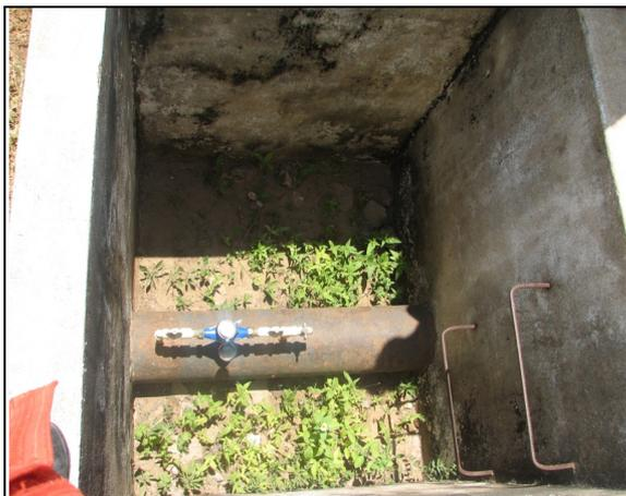
**Foto 38** – Caixa da estação pitométrica e macromedidor sem tampa.
