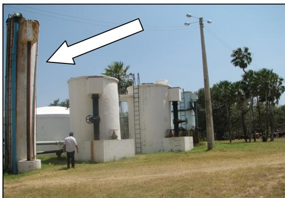
**Foto 13** – Torre de Nível – pintura deteriorada.
