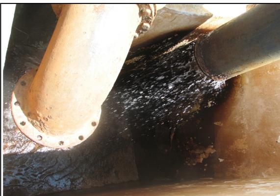
**Foto 9** – Filtro 2 – registros de descarga de fundo e drenagem sem vedação.
