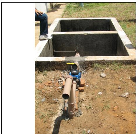
**Foto 40** – Caixa de proteção de registro e tubulação sem tampa/grade.
