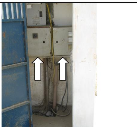
**Foto 27** – EEPT-05 – quadro de comando com pintura deteriorada.
