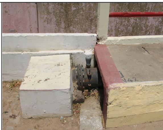
**Foto 43** – Ventosa na adutora de água tratada sem caixa de proteção.
