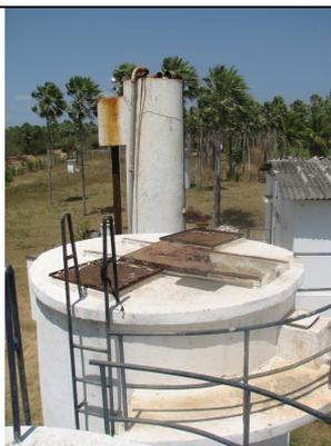
**Foto 8** – Filtro 1 – tampas deterioradas.
