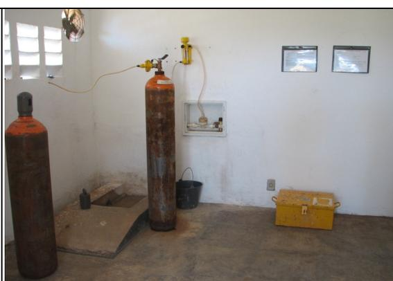
**Foto 17** – Casa de Química - cilindros de cloro – sem balança para controle de consumo.
