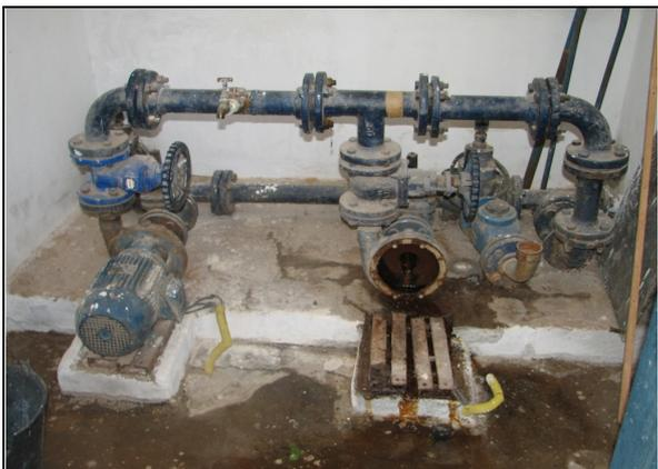
**Foto 32** – EEDR-01 – pintura deteriorada do barrilete e equipamento.
