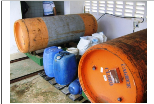
Foto 10 – Armazenamento inadequado de produtos químicos
