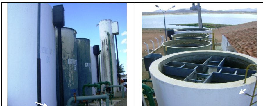
Fotos 7 e 8 – Vista dos flotofiltros e floculadores
