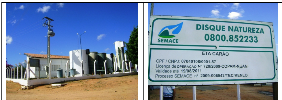
Foto 5 – Vista da entrada da ETA do SAA de Tamboril
