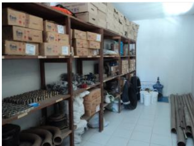
Foto 81 – Almojarifado: armazenamento de materiais.
