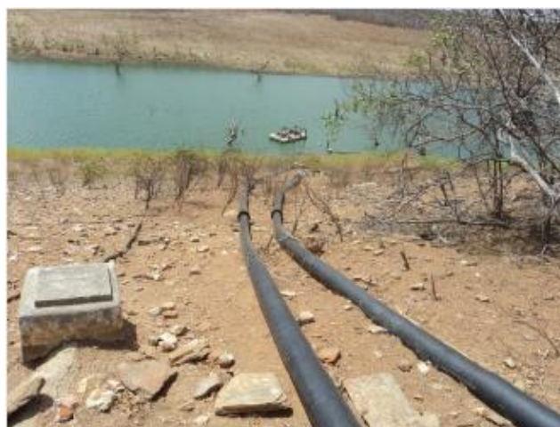
Foto 4 – Açude Jerimum: vista geral da captação.
