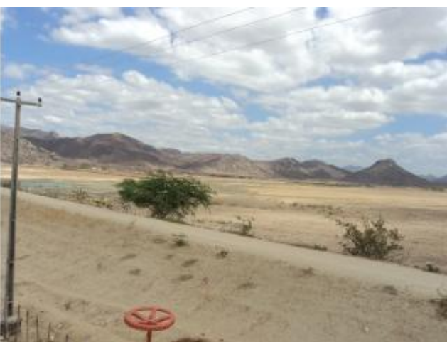
Foto 9 – Açude Paulo Bastos: era utilizado como captação de reforço.
