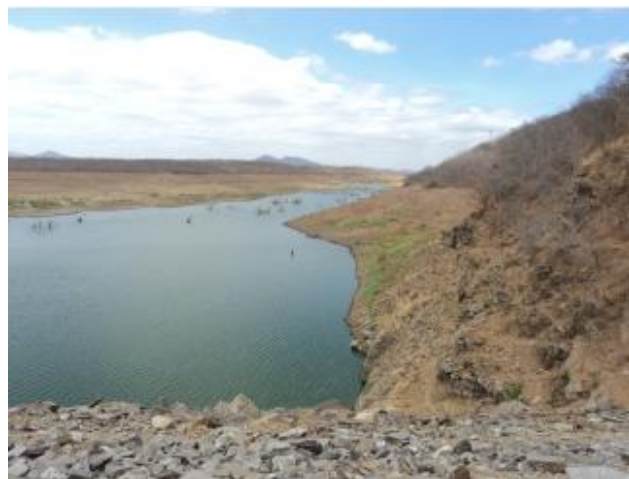
Foto 2 – Açude Jerimum: vista geral do manancial.
