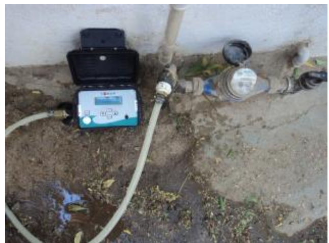
Foto 64 – Rede de distribuição: medição instantânea de pressão na Rua 7 de Setembro, 111 – Bairro Barragem.
