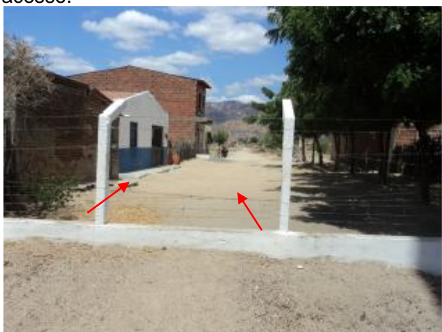
Foto 57 – REL-02: cerca danificada.
