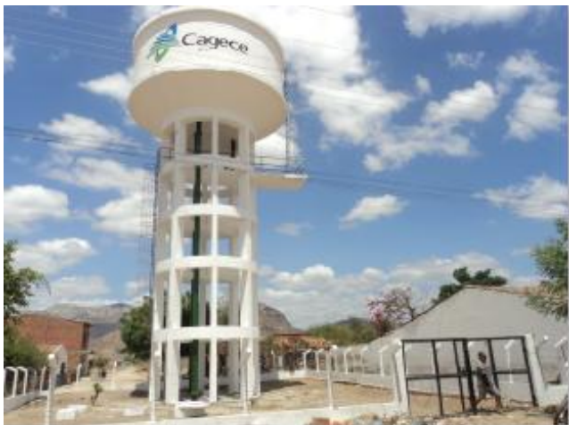
Foto 55 – REL-02: identificação e área de acesso.
