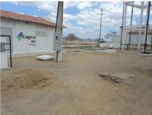
Foto 12 – ETA: condições de limpeza do pátio.
