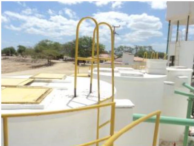
Foto 22 – Filtros 1, 2 e 3: vista superior – tampas de inspeção.
