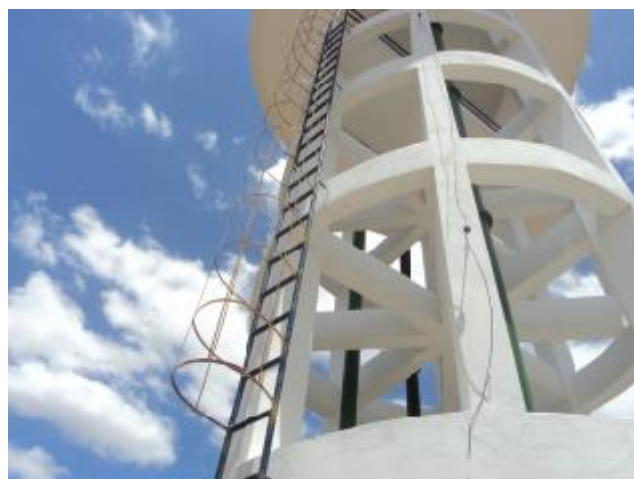
Foto 58 – REL-02: escada com guarda-corpo.
