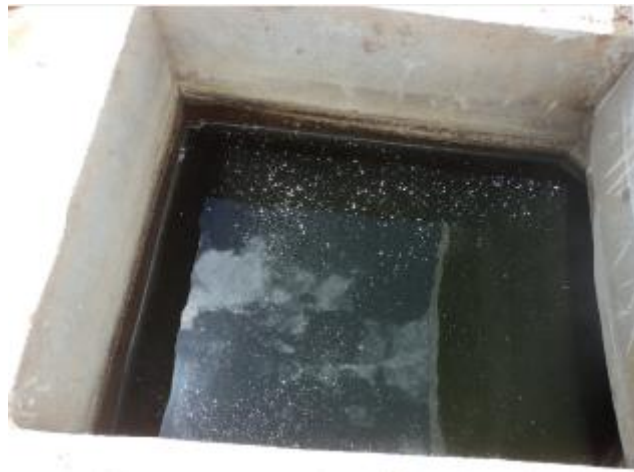
Foto 23 – Filtro 1: presença de materiais em suspensão.
