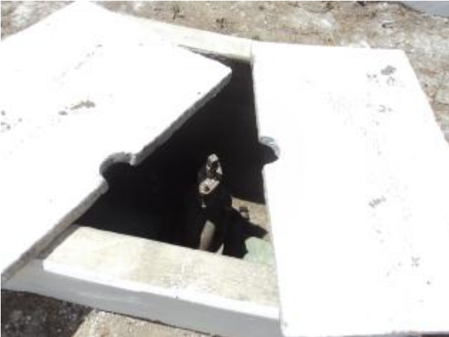
Foto 61 – REL-02: registro com tampa de inspeção.
