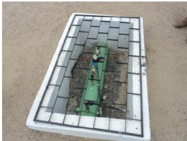
Foto 46 – AAT: medidor proporcional de saída.
