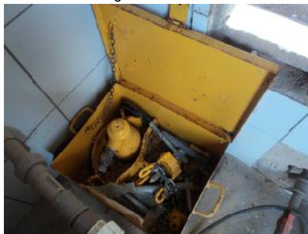
Foto 33 – Casa de química: kit de emergência de cloro gasoso.
