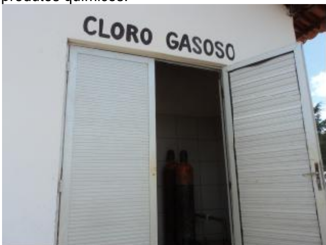
Foto 30 – Casa de química: local de armazenamento do cloro gasoso.
