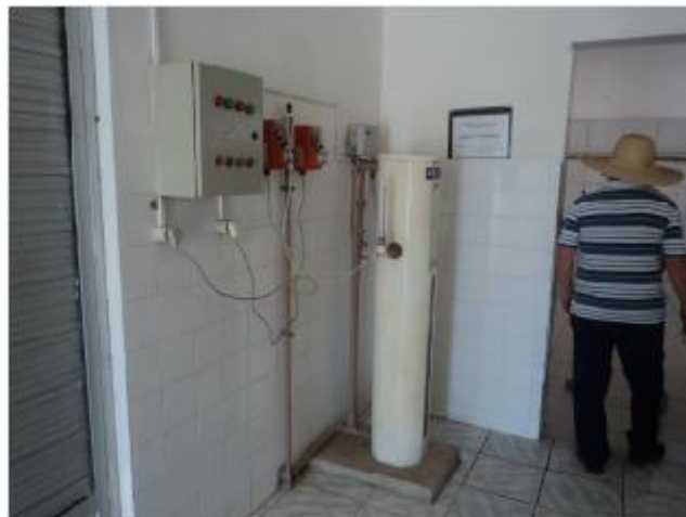
Foto 29 – Casa de química: tanque de fluoretação desativado.
