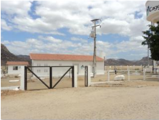
Foto 10 – ETA: área de acesso.
