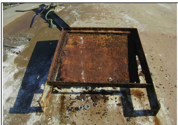
Foto 14 – Tampa de inspeção comprometida pela corrosão – REL-03.
