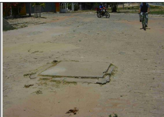
**Foto 02** – Caixa de inspeção de ventosa da adutora de água tratada.
