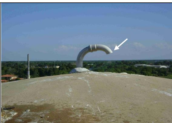
Foto 15 – Tubulação de ventilação sem tela de proteção – REL-03.
