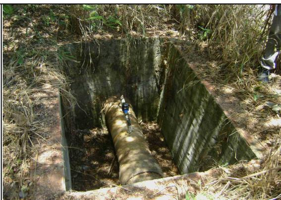
**Foto 04** – Caixa de inspeção do medidor proporcional sem tampa ou grade de proteção.
