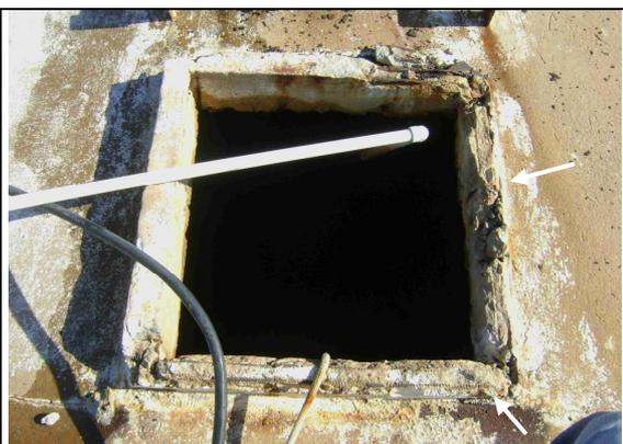
Foto 13 – Borda da inspeção danificada – REL-03.
