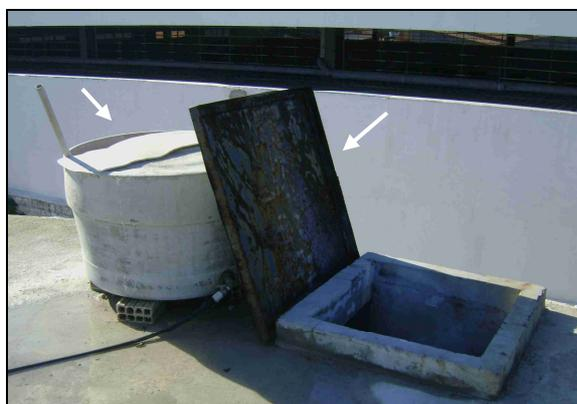
**Foto 11** – RAP-06: Tanque de reforço de cloração (hipoclorito de cálcio) e tampa de inspeção apresentando corrosão.
