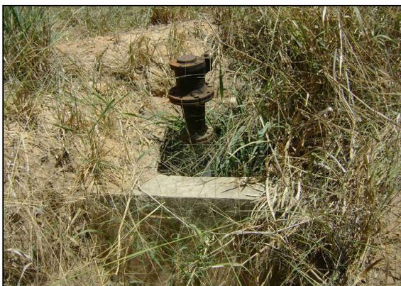
**Foto 03** – Caixa de inspeção de ventosa inadequada.
