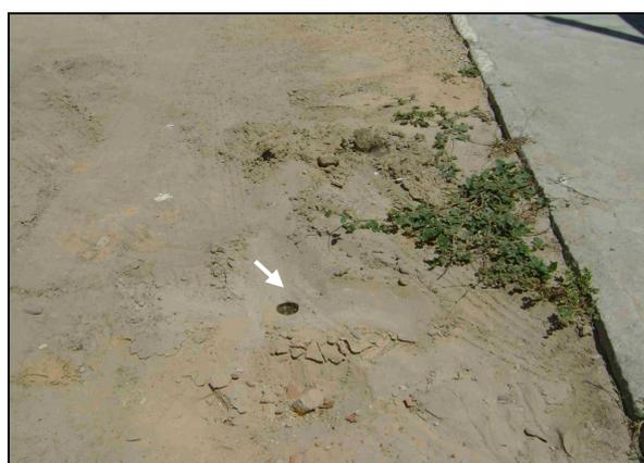
**Foto 26** – Registro de descarga sem caixa de proteção, localizado na Rua Antônio Berlamino.
