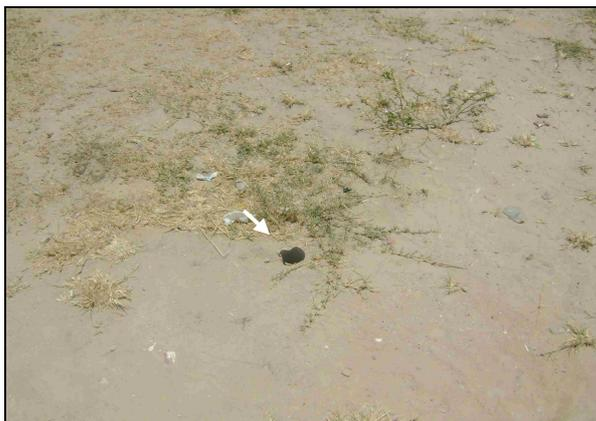
**Foto 22** – Registro de descarga sem caixa de proteção, localizado na Rua Montemor.
