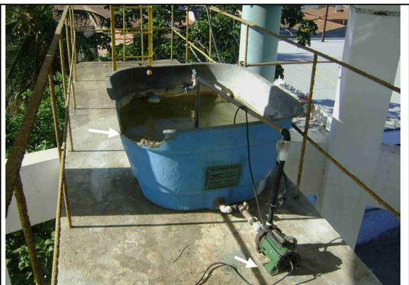
**Foto 17** – Tanque de reforço de cloração (hipocal) danificado – REL-03.
