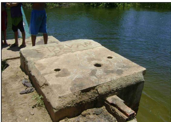
**Foto 01** – Caixa de inspeção de registro de descarga da adutora de água tratada.
