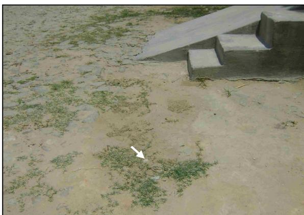
**Foto 24** – Registro de descarga sem caixa de proteção, localizado na Rua Luiz Silva.
