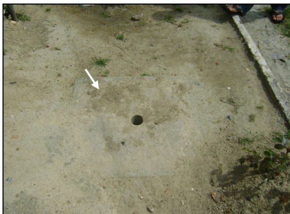
Foto 19 – Registro de descarga localizado na Rua Castanhão Escondido.
