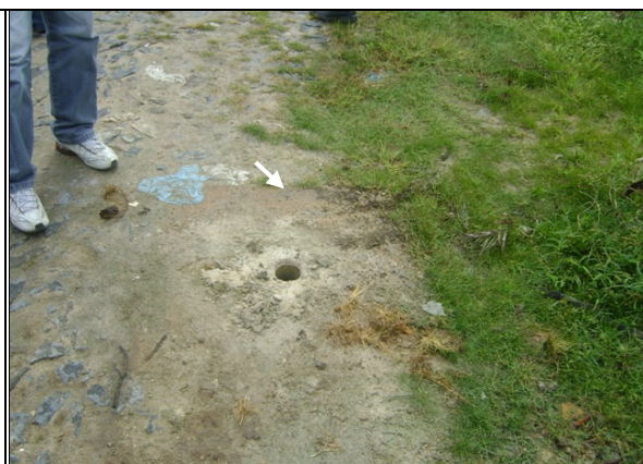
Foto 24 – Registro de descarga localizado na Rua João Ferreira Lima.
