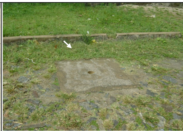
Foto 22 – Registro de descarga localizado na Rua Bier Fontenelle.
