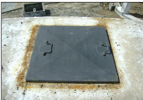
Foto 9 – RAP-02: tampa de inspeção.
