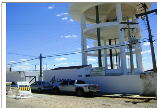
Foto 5 – Vista da entrada da ETA do SAA de Crateús
