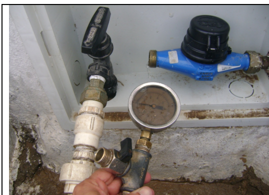
Foto 74 – RDA: medição de pressão no endereço Rua da Lavanderia, 430* - Campo Novo.
