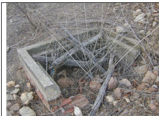
Foto 56 – Adutora de água bruta: caixa de inspeção de registro de descarga.
