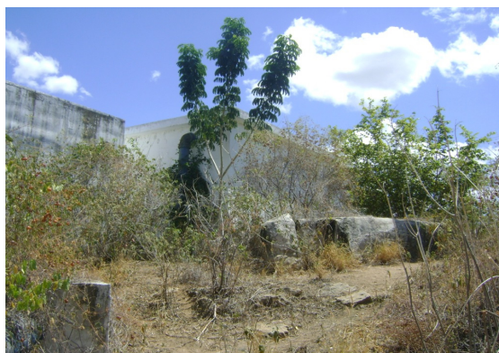
Foto 40 – RAP-02: limpeza da área inadequada.
