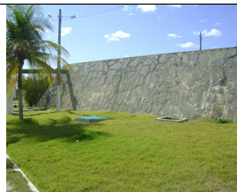
Foto 5 – ETA: vista geral do decantador.
