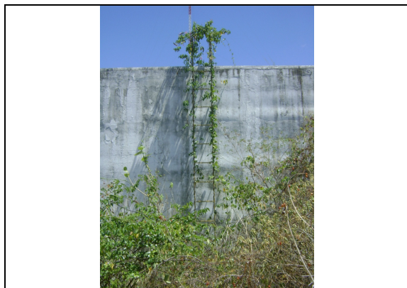
Foto 43 – RAP-02: vegetação na escada de acesso.
