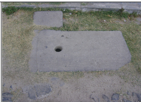
Foto 66 – Registro de descarga localizado na Rua Dona Otília Viana, 26 – Alto São Francisco.
