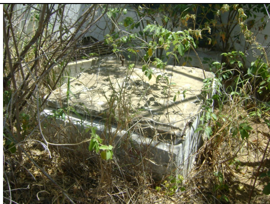
Foto 51 – Estação pitométrica na chegada do RAP-02.
