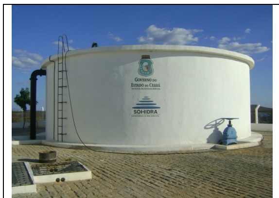
Foto 33 – RAP-01-SOHIDRA: vista geral do reservatório.
