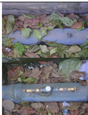
Foto 50 – Macromedidor e estação pitométrica na linha de recalque das elevatórias EEAT-01 e EEAT-02, com caixa deteriorada.
