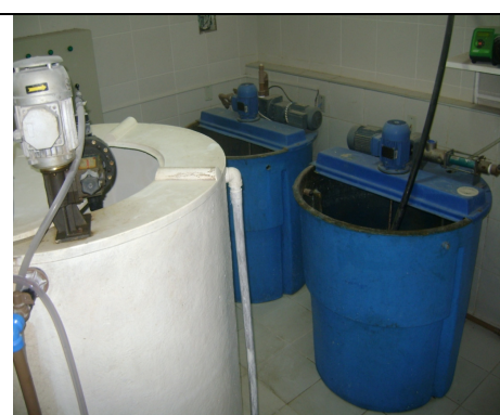
Foto 7 – ETA: área interna da Casa de Química.
