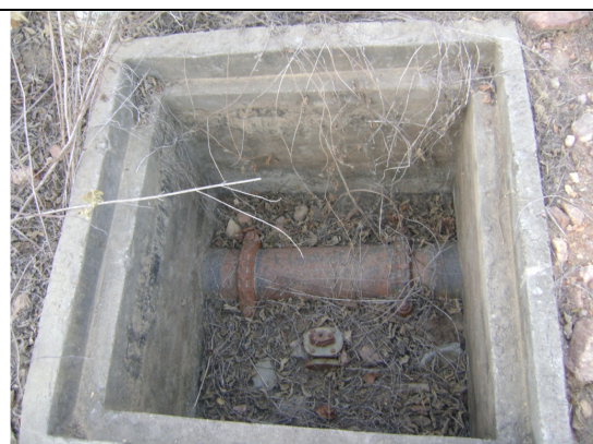
Foto 57 – Adutora de água bruta: caixa de inspeção de registro de descarga.
