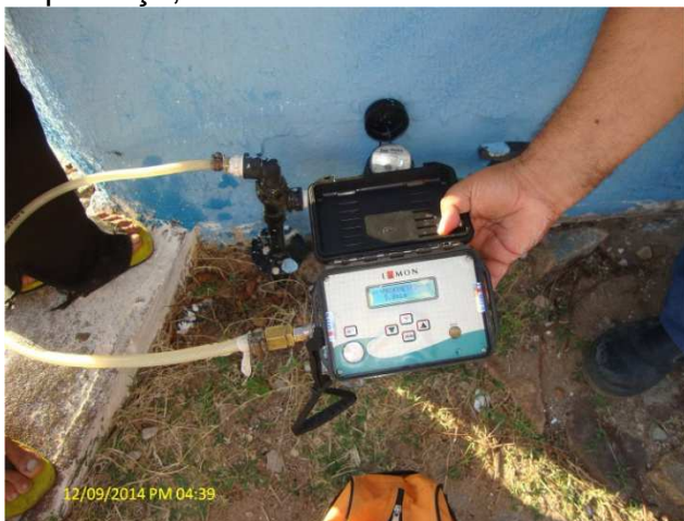
Foto 34 – Medição de pressão na Rua Valter Sales, s/n.
