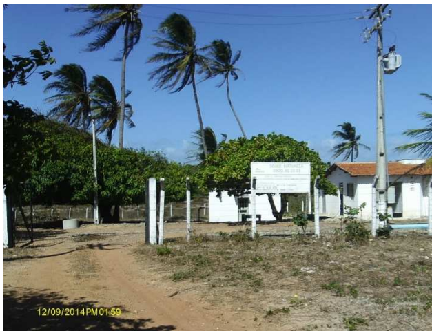
Foto 9 – Vista externa da ETA com portão de acesso livre sem tranca.
