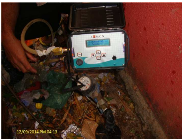
Foto 32 – Medição de pressão na Rua Boa Esperança, nº 2 – Bairro Aldeota.
