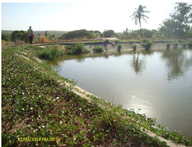
Foto 27 – ETE: talude com vegetação na lagoa de maturação.
