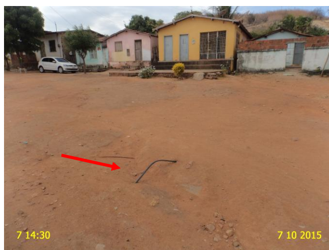
Foto 10 - RDA: ramal de ligação predial exposto.
