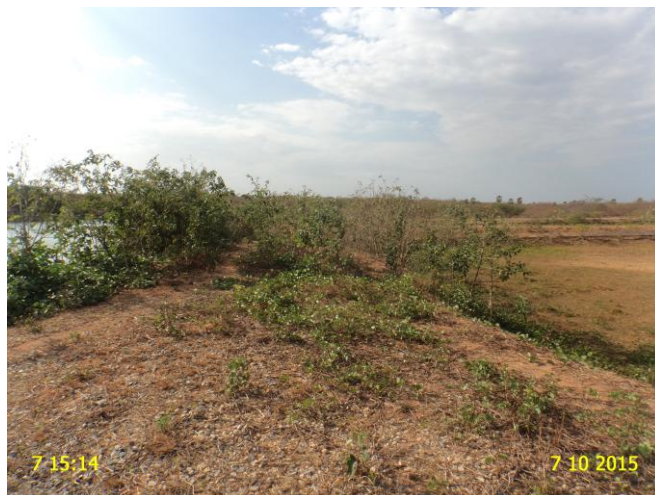
Foto 3 - ETE: vegetação excessiva.
