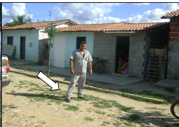
Foto 46 – Registro de descarga soterrado, localizado na Rua Davi Barros, São Francisco.
