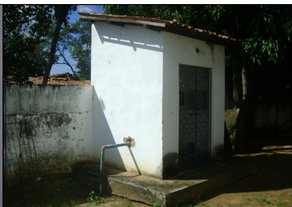
Foto 32 – Prédio de abrigo da EE-03.
