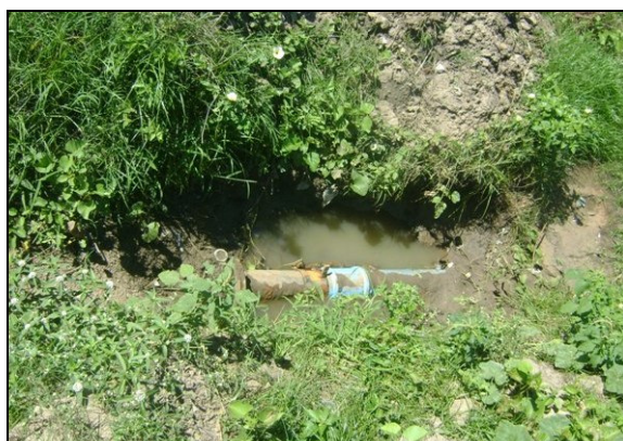
Foto 42 – Adutora exposta, próximo à captação.
