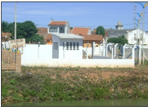
Foto 26 – Futuro prédio de abrigo da EE-01.
