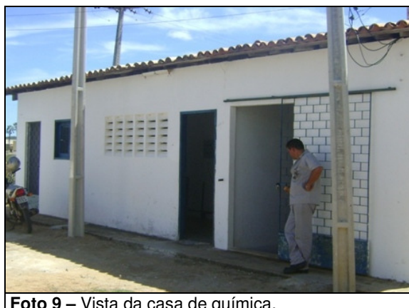
Foto 9 – Vista da casa de química.
