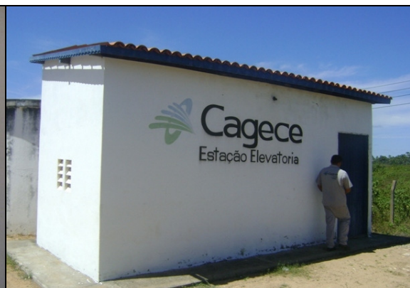
Foto 35 – Prédio de abrigo da EE-04.
