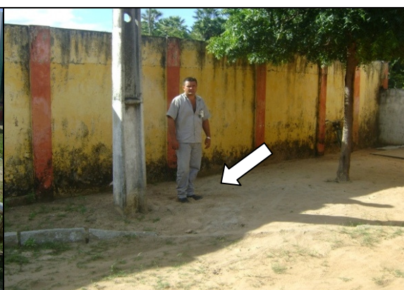
Foto 48 – Registro de descarga soterrado, localizado na Rua Seis, Centro.
