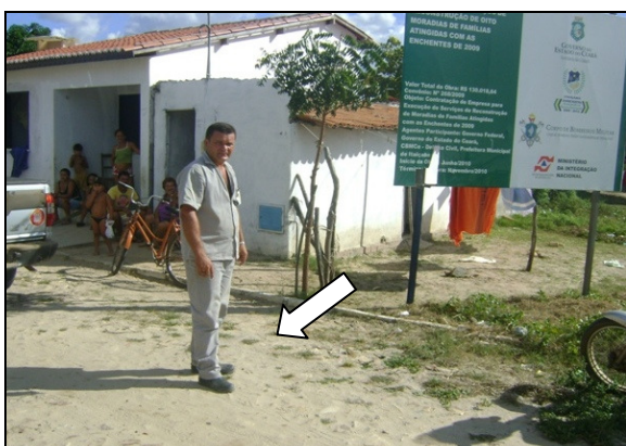
Foto 47 – Registro de descarga soterrado, localizado na Rua Francisco Torres, São Francisco.
