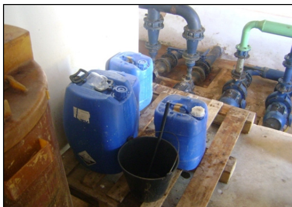
Foto 16 – Armazenamento adequado de materiais e produtos químicos.
