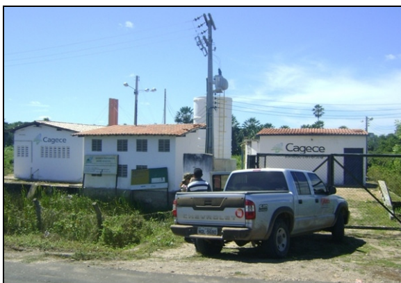
Foto 3 – Entrada da ETA.
