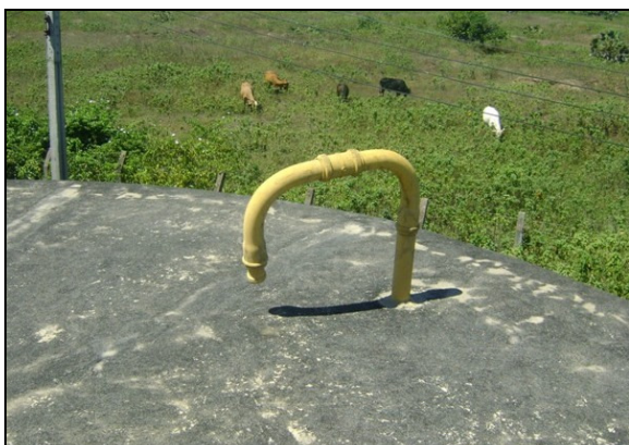
Fotos 38 e 39 – Tubos de ventilação do RSE-01.
