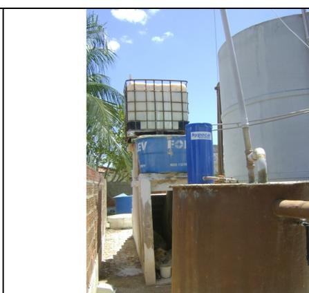
**Foto 16** – Reator UASB: ausência de misturadores e dosadores.
