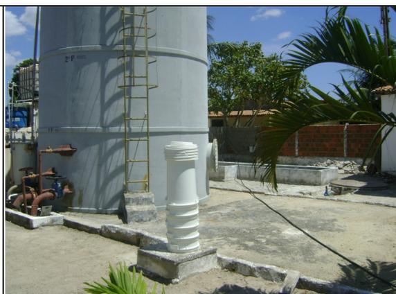
**Foto 14** – Reator UASB: ausência de dispositivo de medição de vazão.
