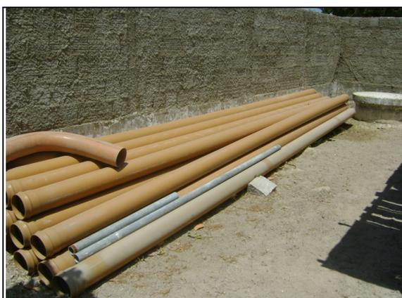
**Foto 17** – Reator UASB: tubulação disposta na área, de forma inadequada.
