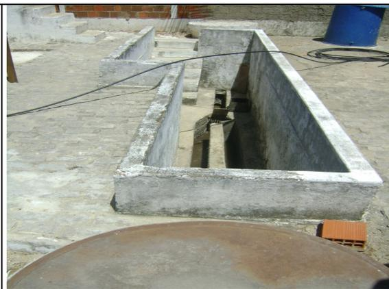
**Foto 11** – Estrutura de chegada do esgoto bruto.
