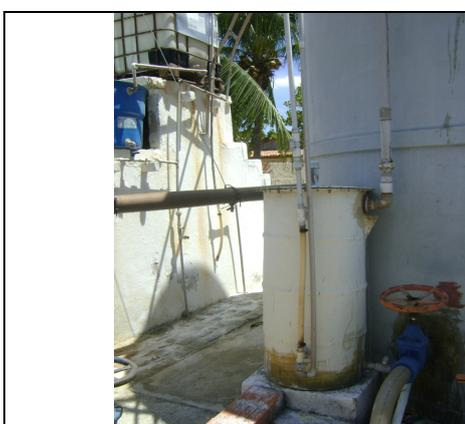
**Foto 15** – Reator UASB: ausência do funcionamento do sistema de coleta e tratamento dos gases.
