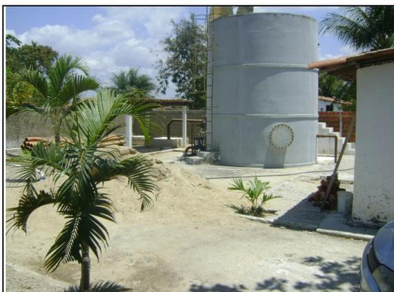
**Foto 13** – Reator UASB: ausência de identificação.
