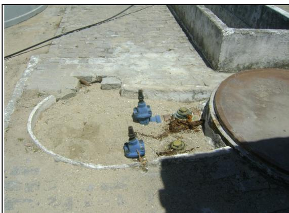
**Foto 5** – EEE Itaitinga: barrilete de recalque do poço de sucção, encoberto.
