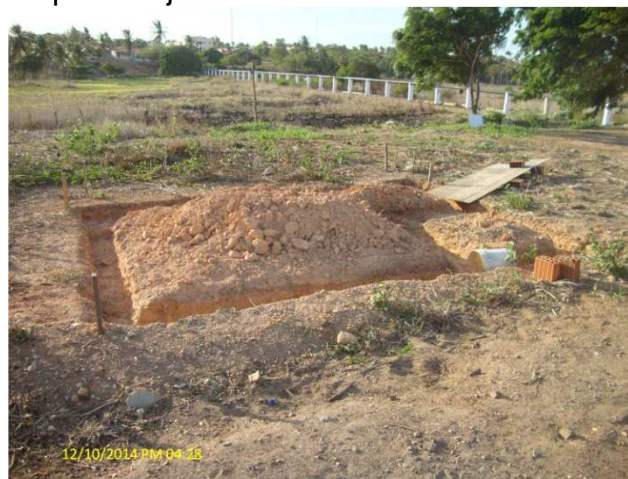
Foto 4 – Ausência de edificação de apoio para o operador de ETE.
