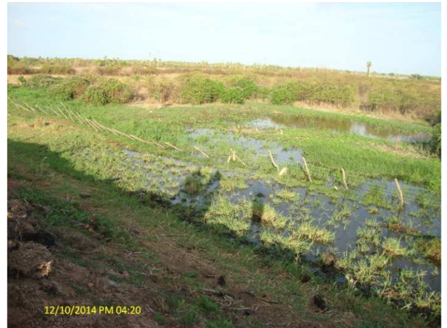
Foto 27 – Área da ETE alagada por esgoto.
