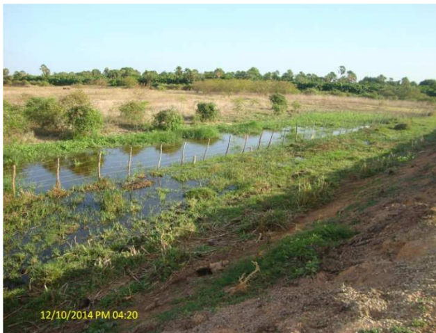
Foto 28 – Área da ETE alagada por esgoto.
