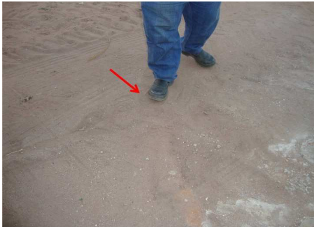
Foto 16 – Registro de descarga soterrado e sem caixa de proteção, localizado na Rua Eusébio.
