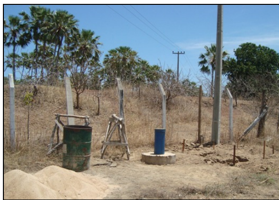
Foto 9 – Poço novo em instalação.
