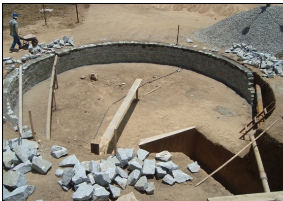
Foto 12 – Reservatório em construção.
