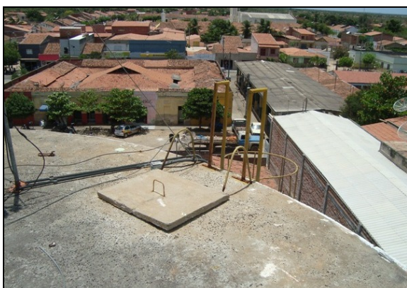
Foto 36 – Inspeção do REL-01.
