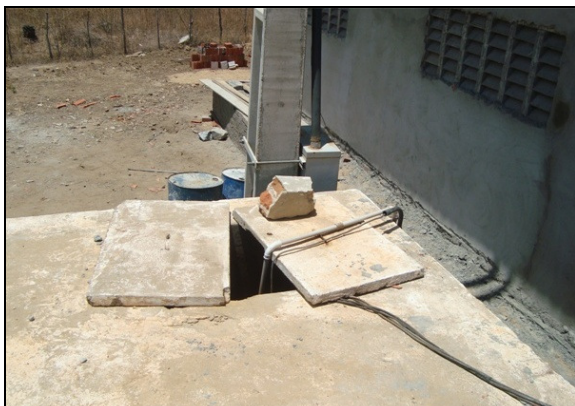
Foto 32 – Inspeção do RSE-01.
