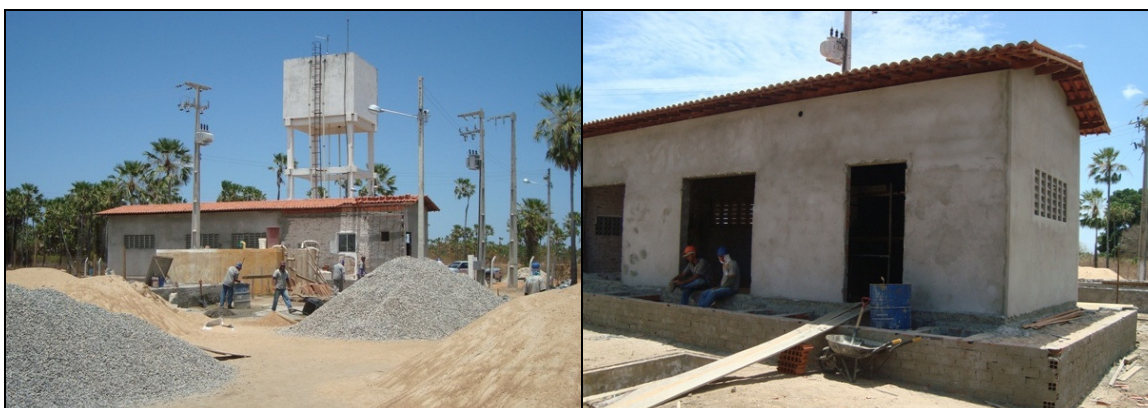
Fotos 10 e 11 – Vistas da casa de química em construção.
