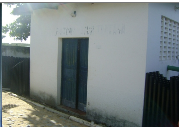
Foto 34 – Prédio de abrigo da EE-03.
