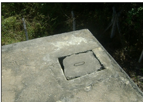
Foto 39 – Inspeção do RAP-01.
