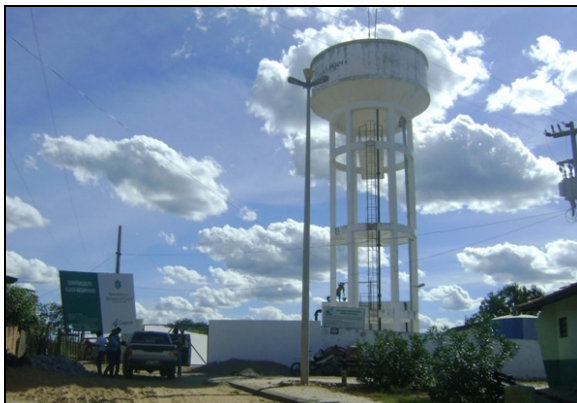
Foto 3 – Entrada da ETA.
