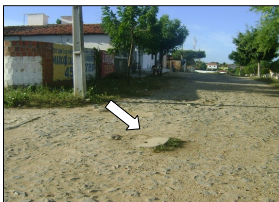
Foto 55 – Registro de descarga, com tampa quebrada, localizado na Rua Simplício de Paula Galvão, Centro.
