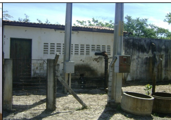
Foto 30 – Prédio de abrigo da EE-02.
