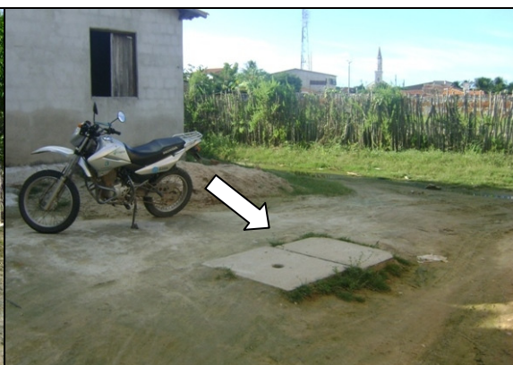
Foto 54 – Registro de descarga, localizado na Rua Simplício de Paula Galvão, Centro.
