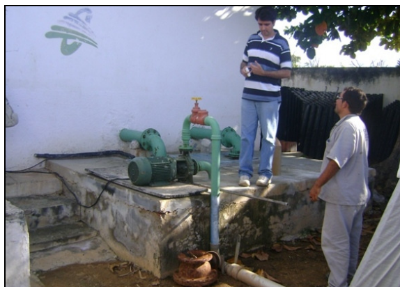
Foto 45 – Vista do Poço de Reunião.
