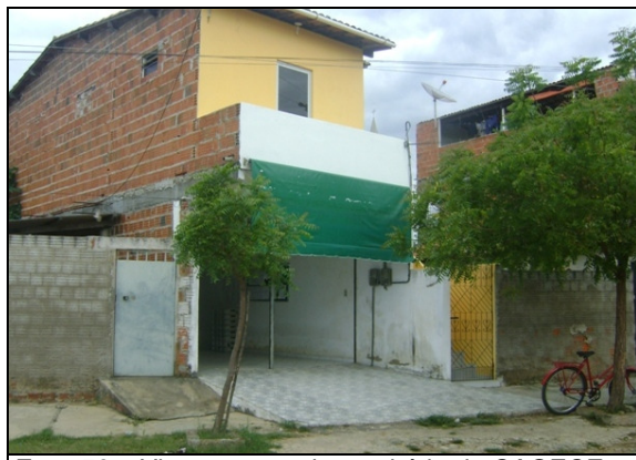
Foto 56 – Vista externa do escritório da CAGECE.
