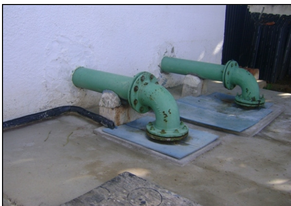
Foto 46 – Inspeção do Poço de Reunião.
