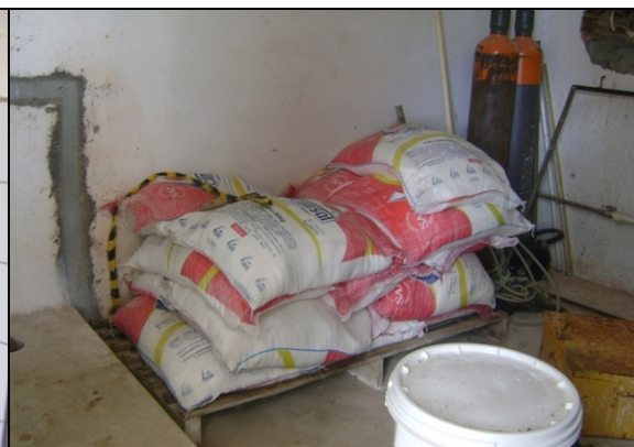
Foto 14 – Armazenamento adequado de materiais e produtos químicos.
