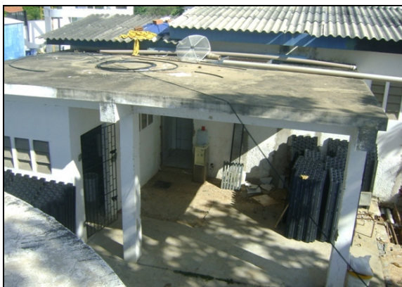
Foto 10 – Vista da casa de química.
