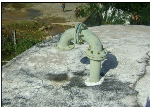
Fotos 43 e 44 – Tubulações de ventilação do RAP-02.
