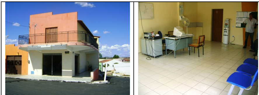
Fotos 47 e 48 – Vistas externa e interna do Escritório
