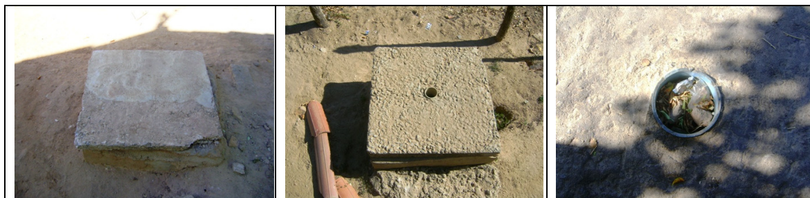
Fotos 42, 43 e 44 – Registros de descarga nas Ruas SDO-34, D. Carminha Aires e Severino Barbosa
