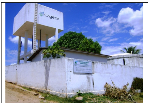
Foto 4 – Vista da ETA do SAA de Piquet Carneiro
