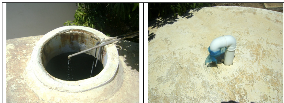
Fotos 27 e 28 – Vistas superiores do RAP-03.
