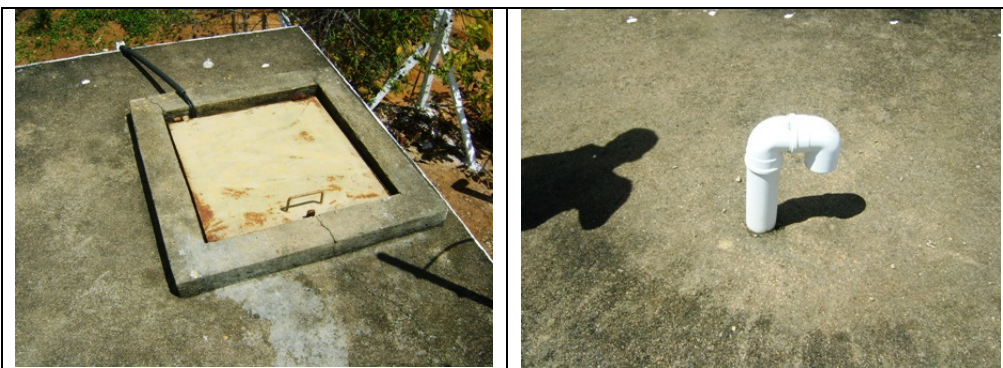
Fotos 24 e 25 – Vistas superiores do RAP-01
