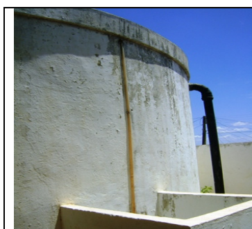
Foto 32 – Medidor de nível no reservatório RAP-03
