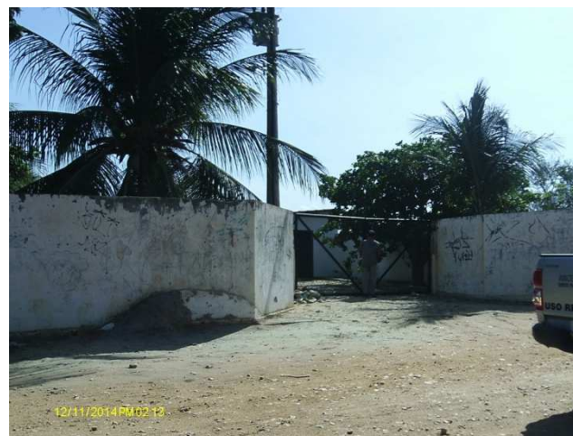
Foto 17 – EEE-03: sem identificação.
