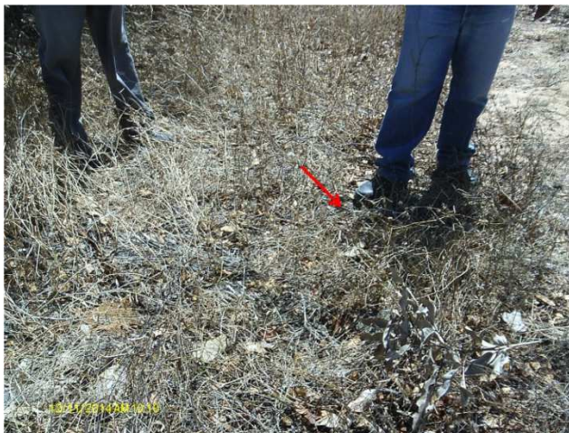
Foto 12 – Registro de descarga soterrado e sem caixa de proteção, localizado na Rua Francisco Henrique de Azevedo.
