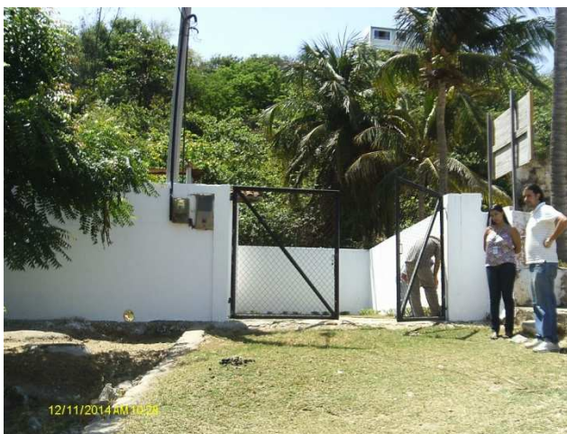
Foto 16 – EEE-02: sem identificação.
