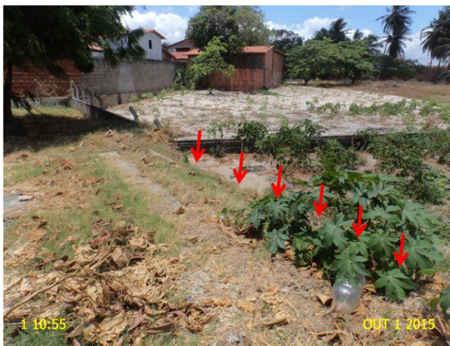
Foto 12 – EEE-02: cerca delimitadora danificada.
