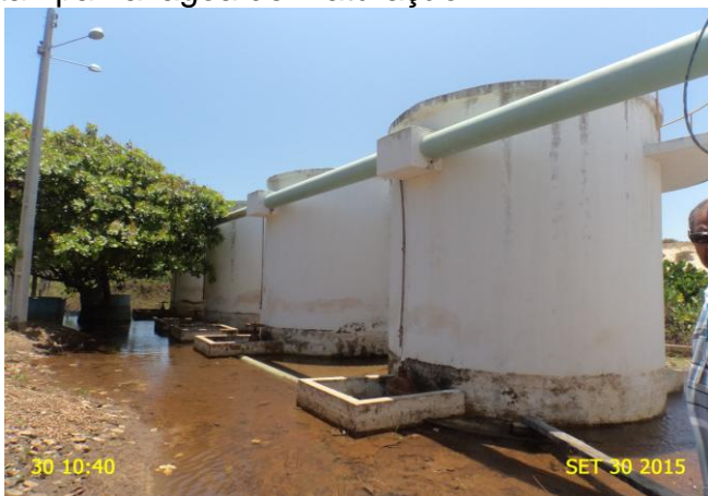
Foto 28 – F-01, F-02, F-03 e F-04 – ausência de identificação.
