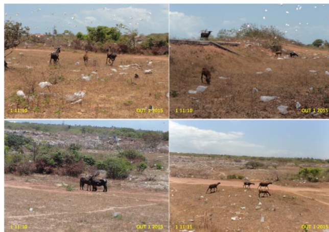
Foto 27 – ETE: presença de animais no interior da ETE.
