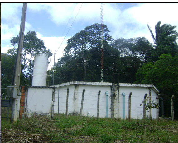
Foto 28 – RAP-05: vista geral.
