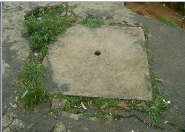
Foto 44 – Caixa de inspeção de registro de descarga na Rua Manuel Pereira Barros, 05.
