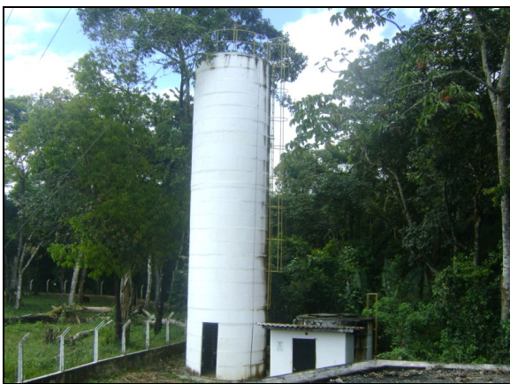
Foto 25 – REL-08: vista geral.
