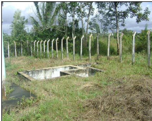
Foto 29 – Área do RAP-05 apresentando inadequadas condições de limpeza e manutenção.
