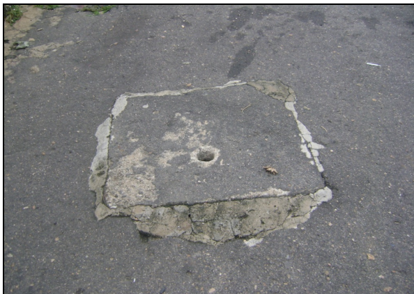
Foto 43 – Caixa de inspeção de registro de manobra na Rua Lamartine Nogueira com Rua Horácio Fontenele Magalhães.
