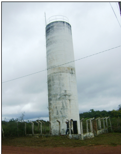
Foto 19 – REL-07: vista geral.
