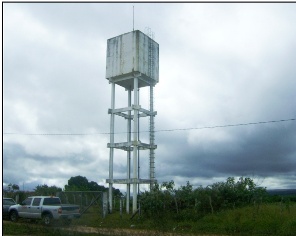
Foto 11 – REL-06: vista geral.
