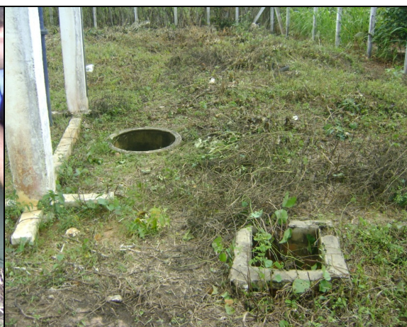
Fotos 15 e 16 – REL-06: caixas de inspeção inundadas e/ou sem tampa.
