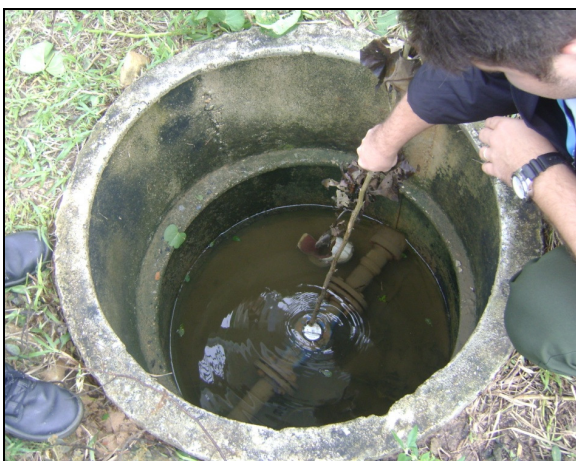
Fotos 15 e 16 – REL-06: caixas de inspeção inundadas e/ou sem tampa.
