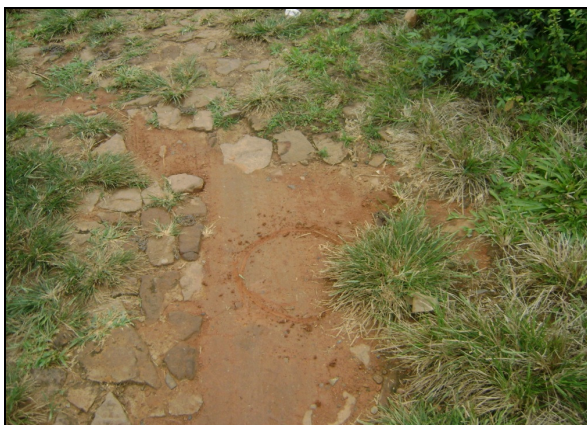
Foto 49 – Local do registro de descarga na Rua SDO 66: soterrado.
