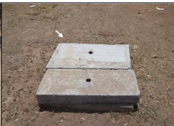
Foto 47 – Registro de descarga localizado na Rua Raimundo Sá Ferreira Lima.
