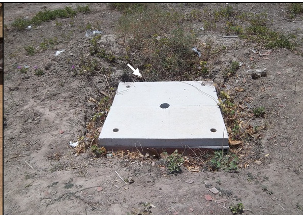
Foto 45 – Registro de descarga localizado na Rua João Alves Carneiro.
