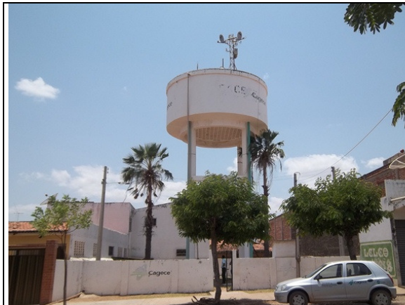
Foto 38 – REL-01: Existência de identificação.
