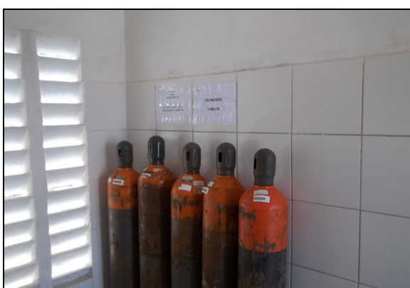
Foto 21 – Dosador de flúor..
