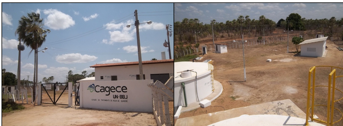
Foto 9 – Vista externa da ETA.
