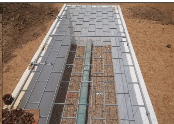
Foto 27 – Adutora de água bruta: caixa de proteção sem macromedição, localizado na saída do PT-04.
