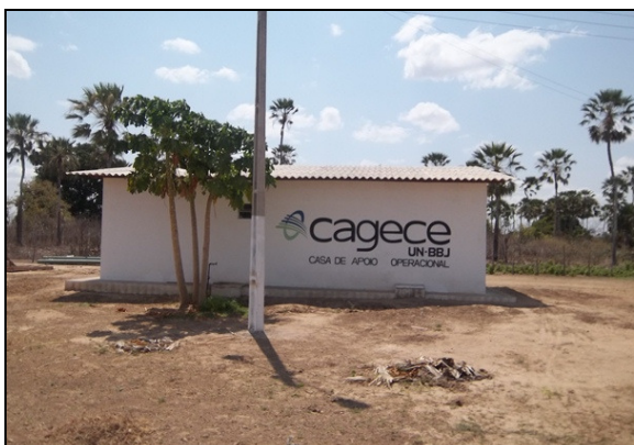
Foto 7 – Casa de Apoio Operacional.
