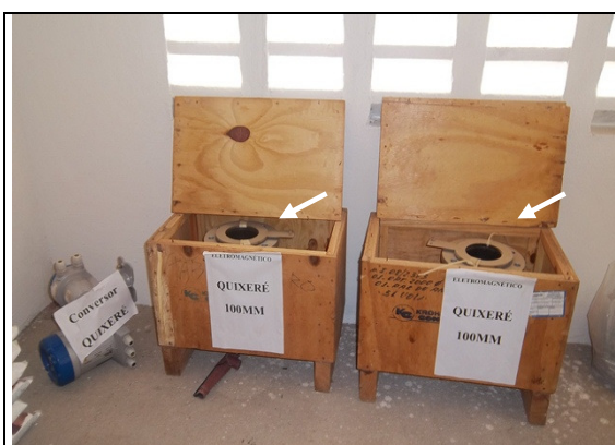
Fotos 28 e 29 – Macromedidores existentes na ETA.
