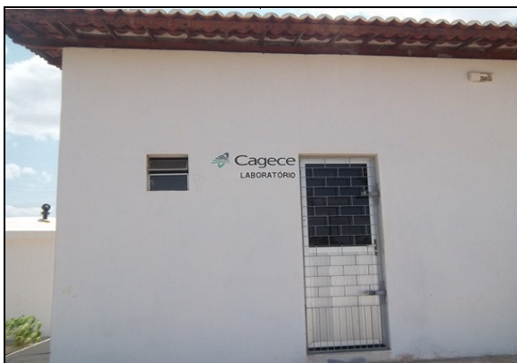
Foto 13 – Laboratório: Vista externa.
