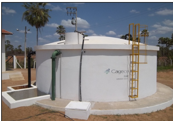
Foto 35 – RAP-01: Existência de identificação.
