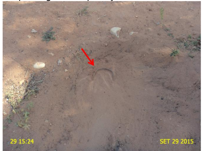
Foto 6 – RDA: registros de descarga soterrado no endereço: Rua SDO 26.
