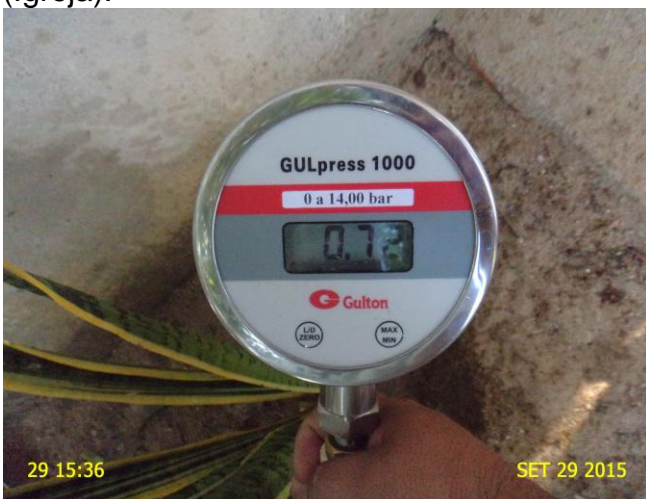
Foto 12 – Medição de pressão Rua Luiza Cipriano de Souza, FNS 12.
