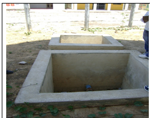
Foto 10 – Área do REL-04, com as caixas do macro medidor e do registro sem grada/tampa
