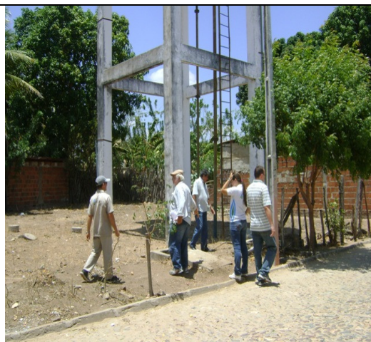
Foto 2 – Área do REL-03, sem cerca de proteção
