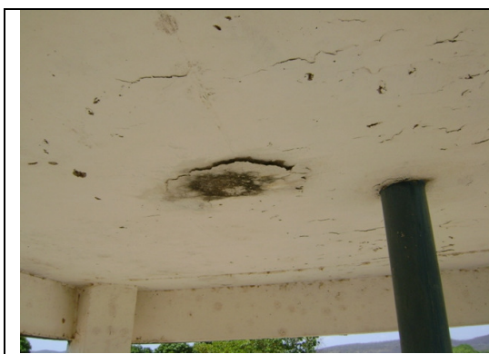
Fotos 8 e 9 – REL-04: com sinais de vazamento e corrosão na ferragem
