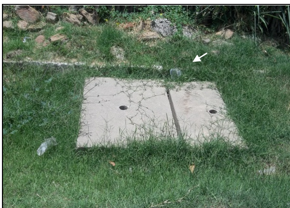
Foto 27 – Registro de descarga localizado na Rua Sargento Demóstenes Lucena.
