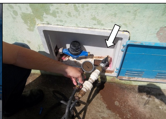
Foto 34 – Medição de pressão na Rua Nel Queiroz, nº 521.
