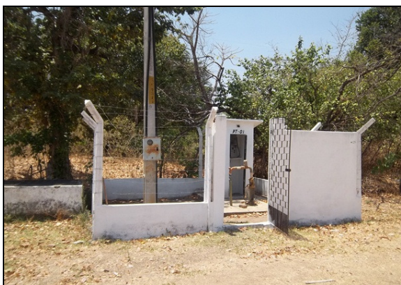
Foto 1 – Poço PT-01: Vista externa.
