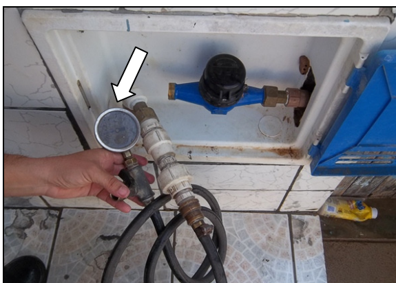
Foto 31 – Medição de pressão na Rua José Alves Bezerra, nº 665.
