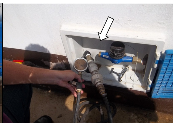
Foto 32 – Medição de pressão na CE 138, s/n.
