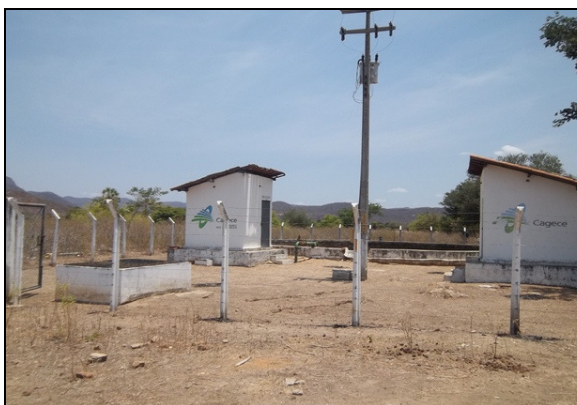
Foto 4 – Poço PA-01: Vista externa.
