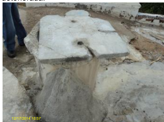
Foto 40 – ETE Chico Braz: tampa improvisada no tanque de mistura.
