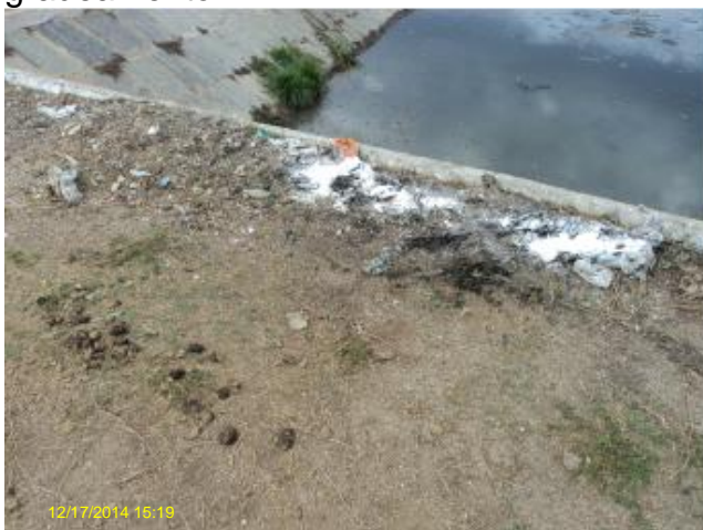
Foto 8 – ETE Campo Novo: secagem do lodo ao lado das lagoas.
