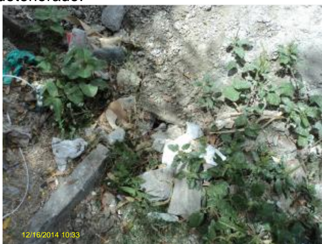
Foto 57 – RDA: registro de descarga sem caixa na Rua Santa Isabel, nº 33.
