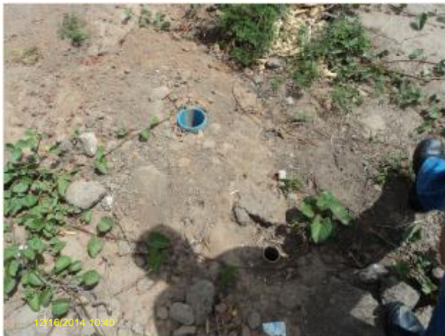
Foto 59 – RDA: registro de descarga sem caixa na Rodovia do Contorno (Próx. ao Posto Rodoviário)
