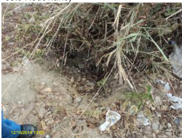
Foto 61 – RDA: registro de descarga sem caixa na Rua Juvêncio Alves, 1053.
