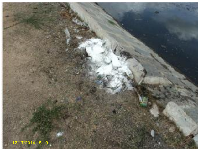
Foto 7 – ETE Campo Novo: secagem do lodo ao lado das lagoas.
