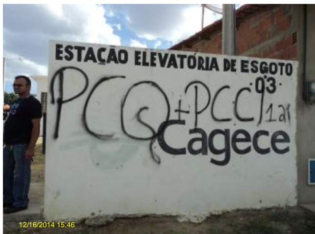
Foto 23 – EEE 03 (Mutirão): pintura deteriorada.
