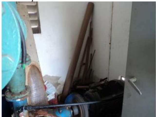
Foto 21 – EERD-01 Booster Putiú: condições de organização e limpeza.
