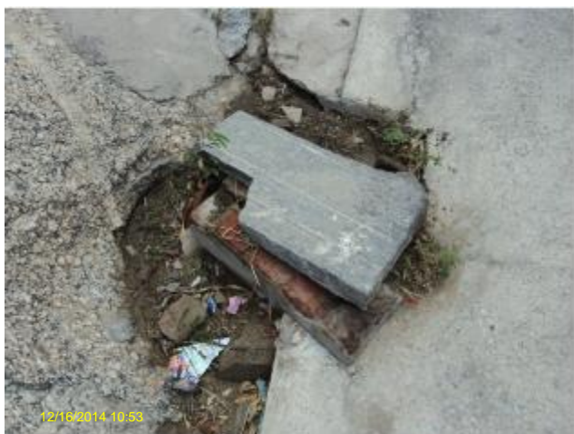
Foto 62 – RDA: registro de descarga sem caixa na Rua Doutor Batista de Queiroz, 258.
