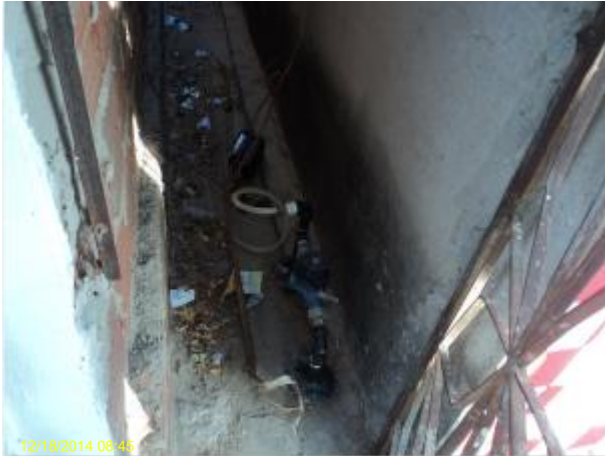
Foto 1 – RDA: medição contínua de pressão na Rua da Estrela, nº 499.
