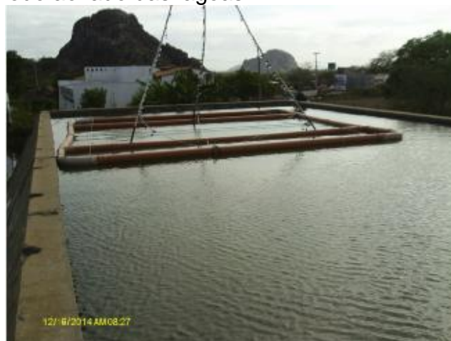
Foto 9 – ETA – Decantador: ausência de passarelas com guarda-corpos.
