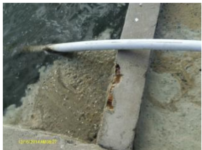
Foto 51 – ETA – Decantador: presença de lodo.
