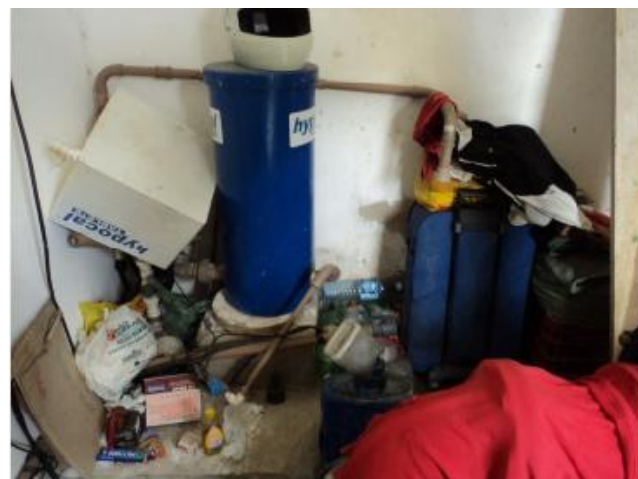
Foto 20 – EERD-01 Booster Putiú: condições de organização e limpeza.
