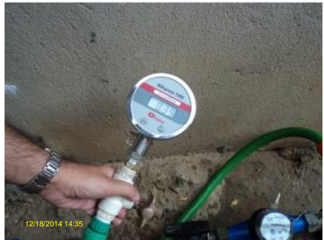
Foto 5 – RDA: R. Francisco Severino Figueiredo, nº 233 – Carrascais – 3,9 mca.
