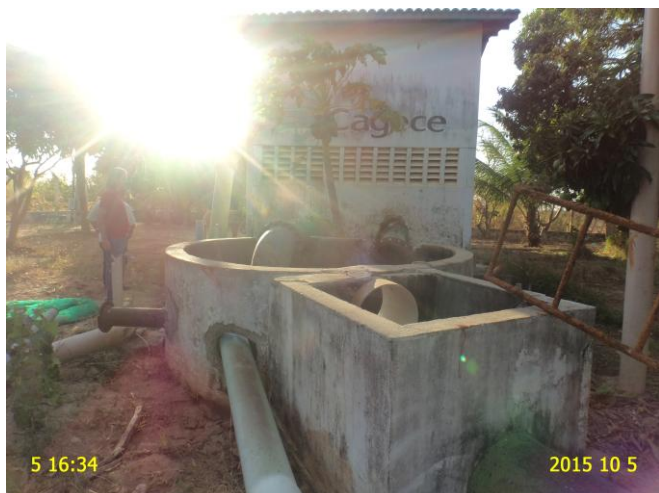
Foto 9 - EEPR-01 Poço Verde: ausência de identificação.
