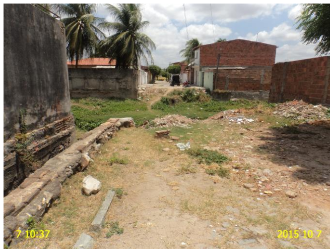
Foto 39 – RCE: lançamento de esgoto à céu aberto: Riacho das Almas.
