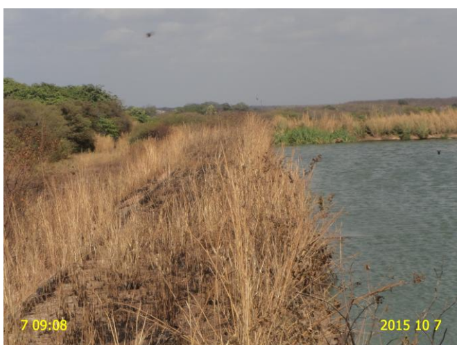
Foto 23 - ETE: vegetação excessiva, impedindo o acesso às lagoas de maturação LM B1 e LM B2.
