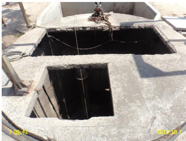
Foto 20 - EEE-01: poço de sucção descoberto.
