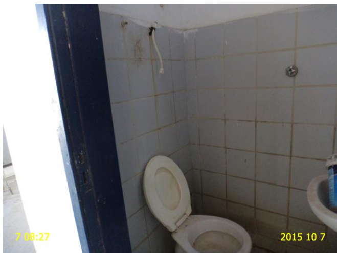
Foto 19 - EEE-05: banheiro sem caixa de descarga.
