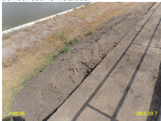
Foto 6 - ETE: ausência de leito de secagem.
