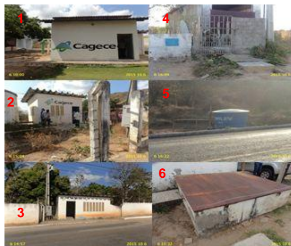
Foto 12 - Elevatórias de água EEAT-03 (1), EERD-03 (2), EERD-04 (3), Bosster Julio I (4), Booster Julio II (5) e Booster Área Nobre (6): ausência de identificação.
