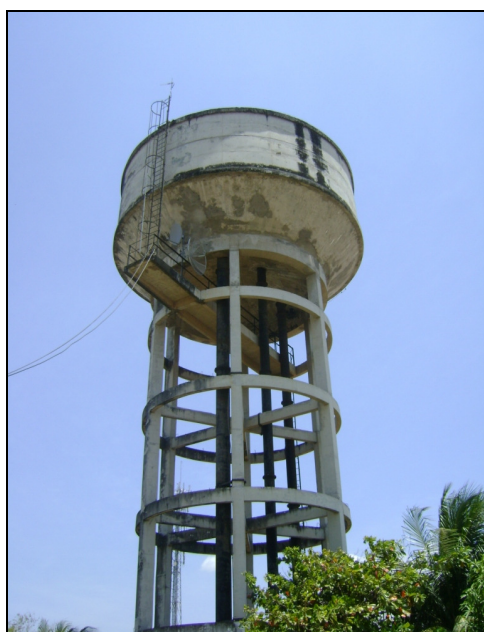
Foto 13 – REL: vista geral.
