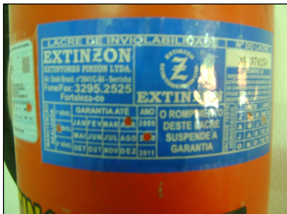
Foto 23 – Extintor com prazo de validade expirado na loja de atendimento no bairro Jereissati.
