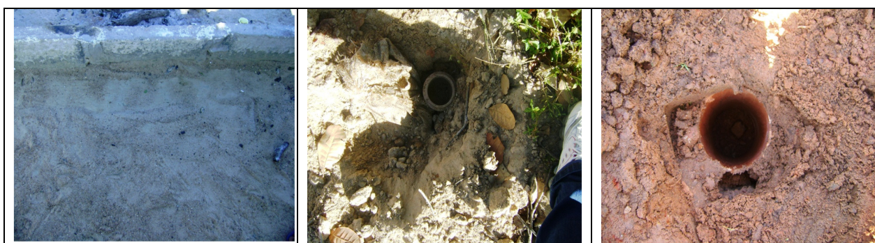
Fots 49, 50 e 51 – Registros de descarga nas Ruas Luiz Raposo, Esperança e Trav. Simão Lopes.
