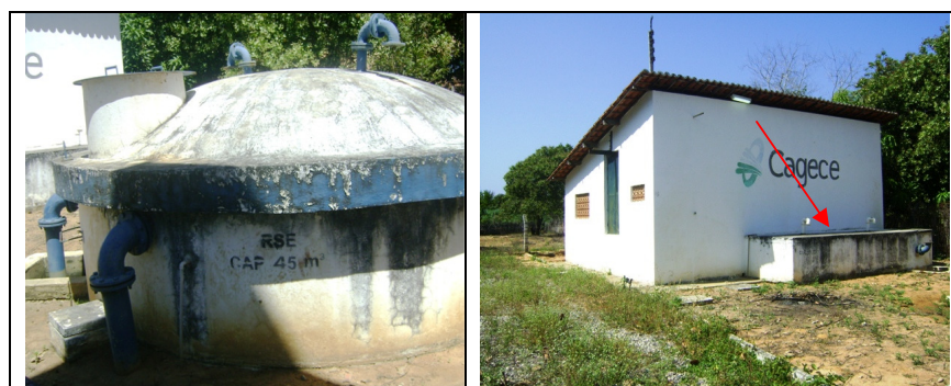
Fotos 33 e 34 – Vistas do RSE-03 e RSE-04 – Distrito de Capivara.
