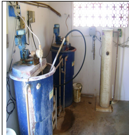
Foto 13 – Tanques de dosagem e sistema de fluoretação.
