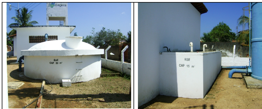
Fotos 28 e 29 – Vistas do RSE-01 e RSE-02 – ETA.
