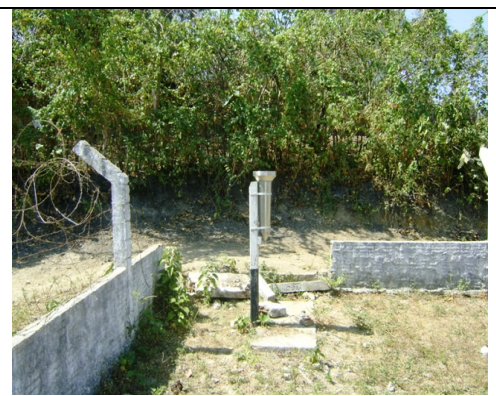
Foto 5 – Cerca da área da captação.
