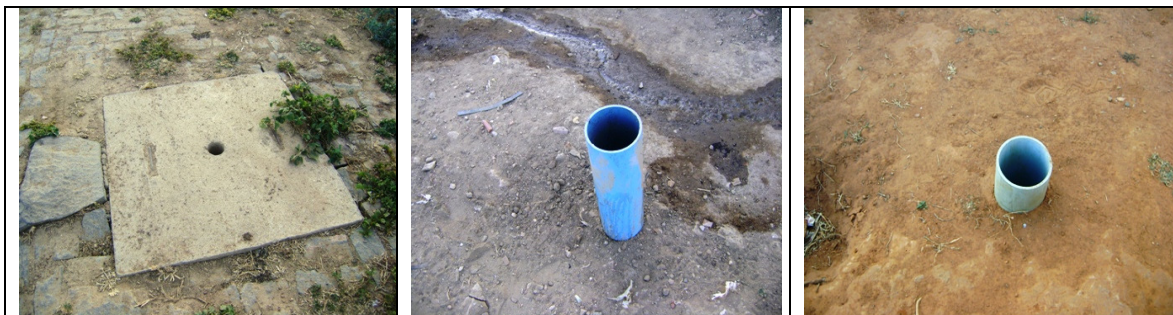
Fotos 48, 49 e 50 – Registros de descarga nas Ruas Antonio Domingos, Prefeito José Ferreira Lima e João Ferreira dos Santos
