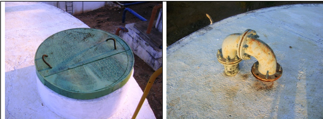
Fotos 38 e 39 – Vistas superiores do RAP-04
