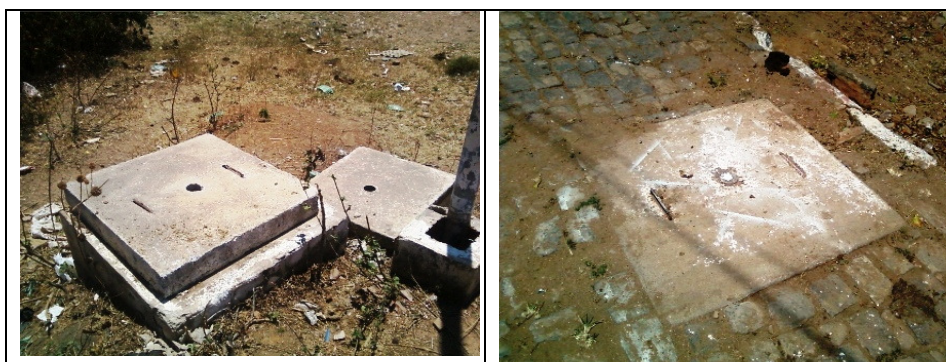
Fotos 54 e 55 – Registro de descarga nas Ruas Francisco Nunes Pereira e Joaquim Vieira Cavalcante
