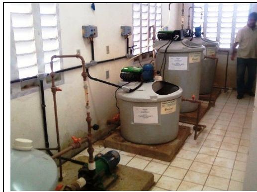
Foto 14 – Tanques dosadores e sistema de fluoretação
