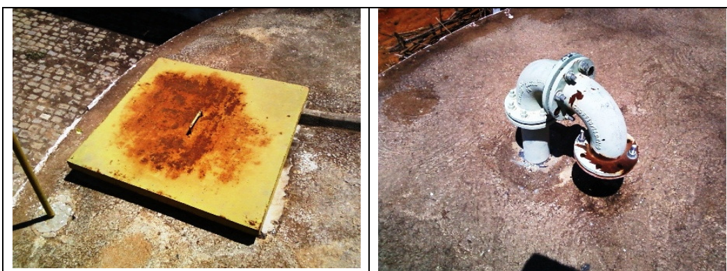
Fotos 29 e 30 – Vistas superiores do RAP-02
