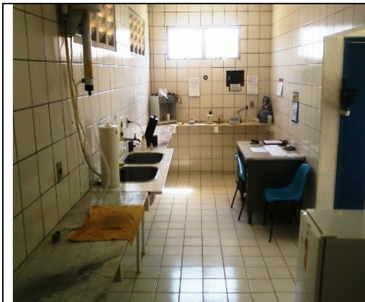
Foto 15 – Vista parcial do laboratório
