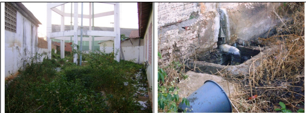
Fotos 42 e 43 – Vistas da área do REL-01
