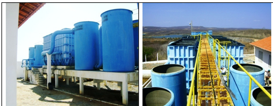
Fotos 7 e 8 – Vistas dos floculadores, decantadores e filtros
