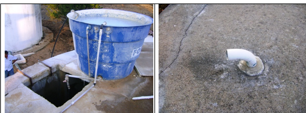
Fotos 35 e 36 – Vistas superiores do RAP-03
