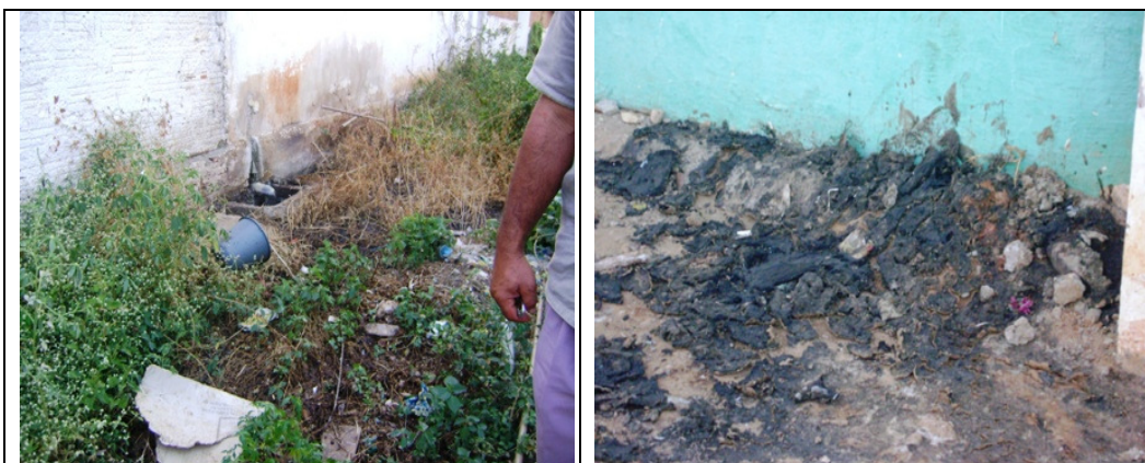
Fotos 44 e 45 – Vistas da área do REL-01
