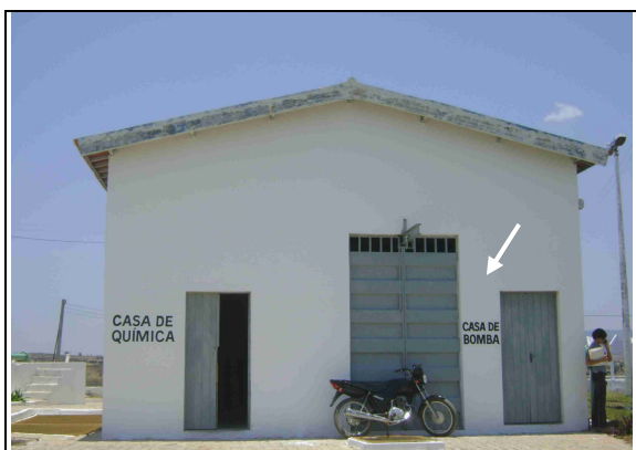
Foto 28 – Casa de comando da EEAT-02 e EEAT-03.
