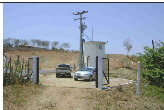
Foto 2 – Área de captação sem sinalização.
