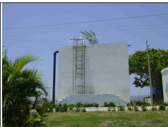
Foto 4 – Vista da ETA: Floco-decantador em fase de conclusão.
