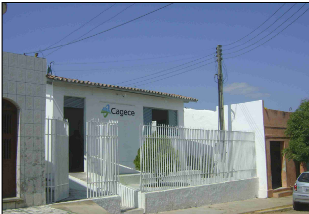
Foto 42 – Vista externa do escritório da CAGECE.
