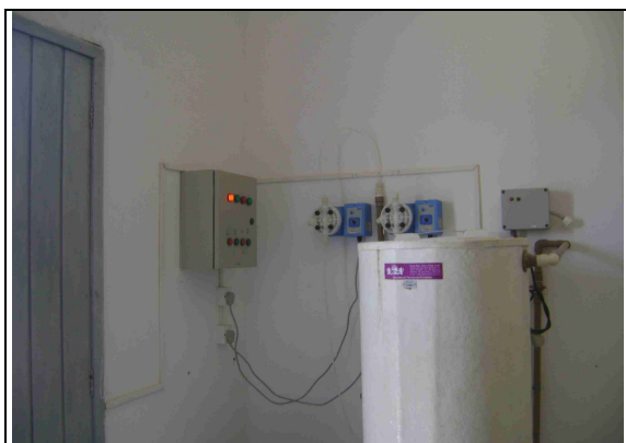
Foto 19 – Sistema de fluoretação.
