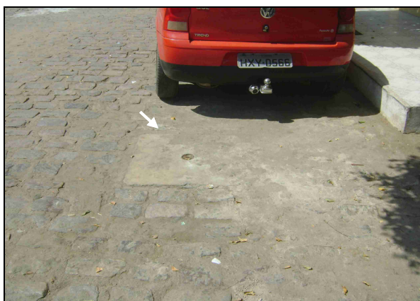
Foto 40 – Registro de manobra localizado na Rua José Sá.
