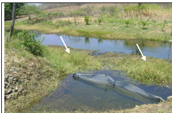
Foto 1 – Riacho Caiçara - Ponto de alimentação do poço de captação.
