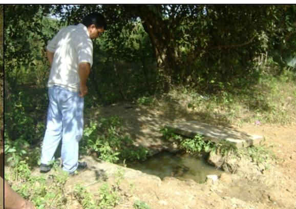
**Foto 42** – Vazamento na ventosa da adutora de água bruta.
