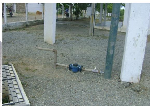
**Foto 44** – Macromedidor de água tratada, para abastecer carros-pipa, na saída do REL-01.
