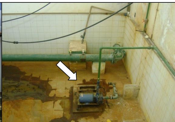
Foto 9 – Bomba dosadora, base danificada e ausência de bomba reserva.
