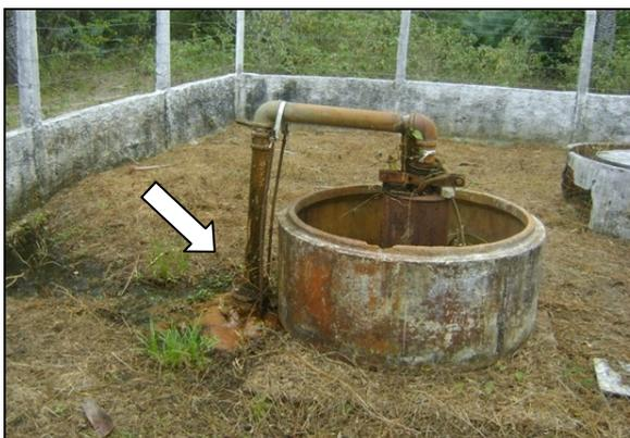
**Foto 22** – Vazamento na tubulação do PT-02.
