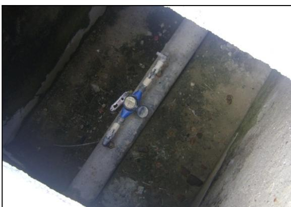
**Foto 43** – Medidor proporcional de água tratada na entrada do REL-01.
