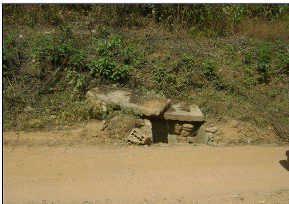
**Foto 41** – Caixa de proteção da ventosa, quebrada.
