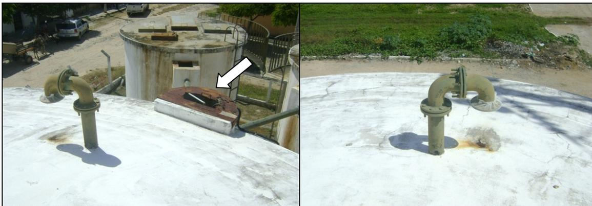
Fotos 34 e 35 – Tampa de inspeção da caixa coletora oxidada e ventilações do RAP-01.
