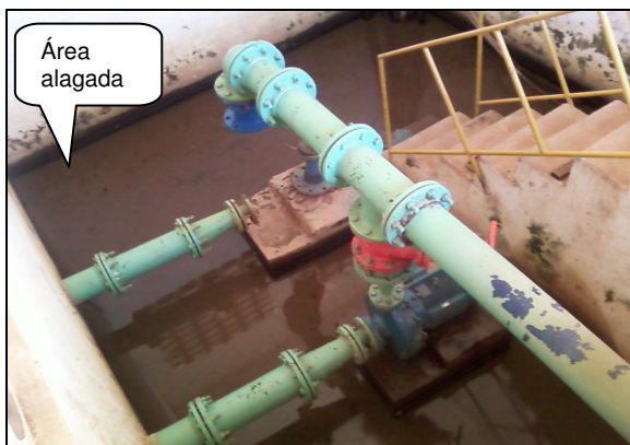
Foto 14 – Conjuntos motor-bombas da EE-02.
