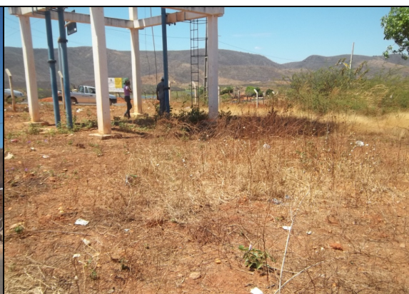
Foto 22 – Área do REL-01: ausência de boas condições de conservação, limpeza e manutenção.
