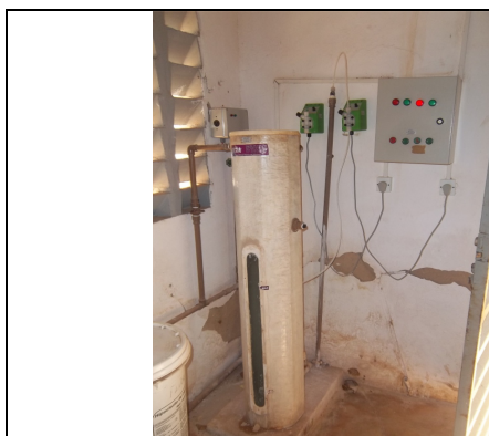
Foto 7 – Sistema de fluoretação.
