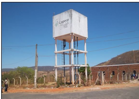
Foto 21 – REL-01: vista geral.
