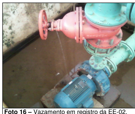
Foto 14 – Conjuntos motor-bombas da EE-02.
