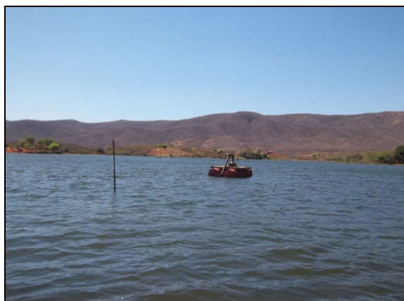
Foto 1 – Vista da captação - Açude Junco.
