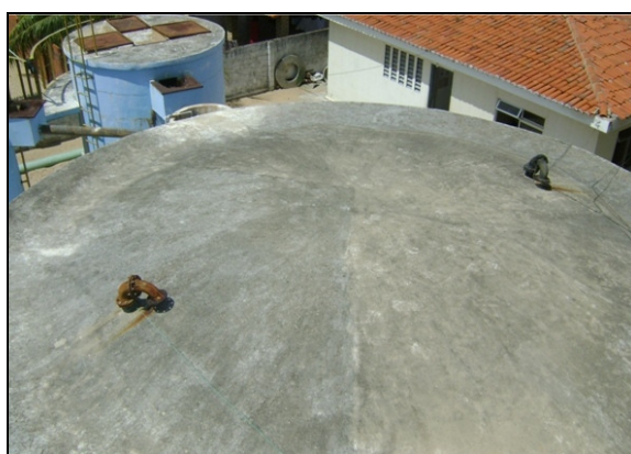
Foto 31 – Ventilações do RAP-01.
