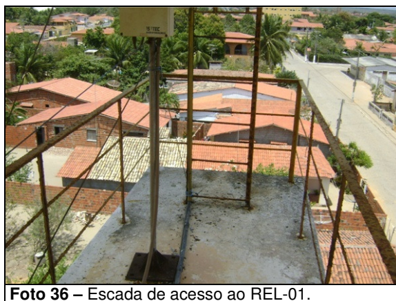
Foto 36 – Escada de acesso ao REL-01.
