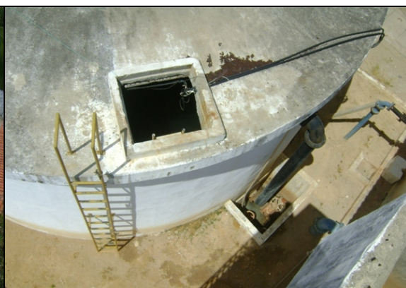
Foto 30 – Inspeção e escada do RAP-01.
