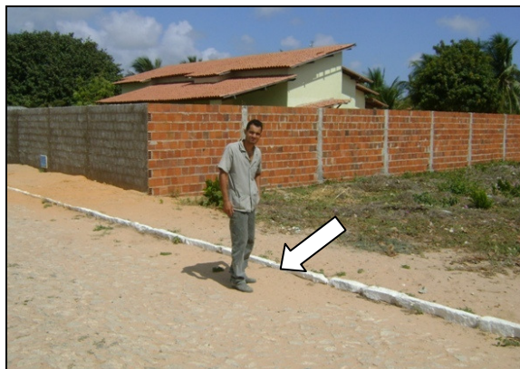
Foto 42 – Registro de descarga na Rua Joaquim Facó.
