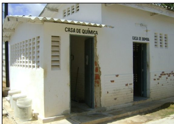
Foto 9 – Casa de química.
