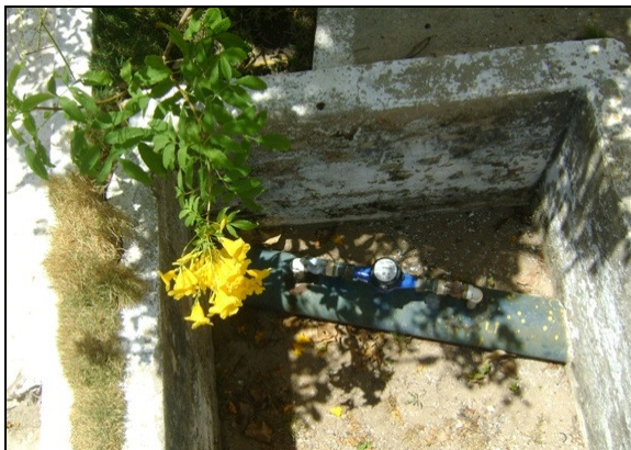
Foto 37 – Medidor proporcional na entrada do REL-01.
