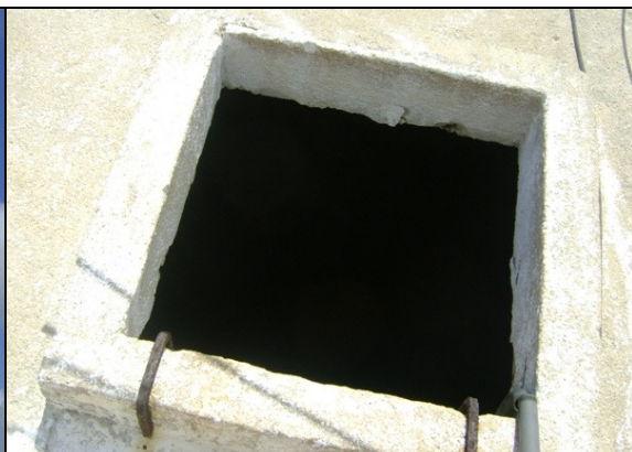
Foto 33 – Inspeção do REL-01.
