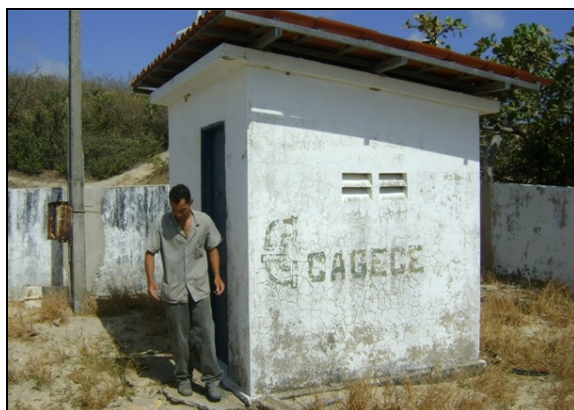
Foto 20 – Casa de comando da EECS-01.
