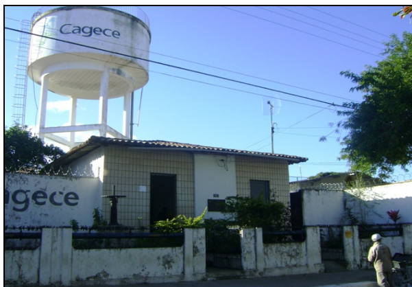
Foto 33 – Vista externa do escritório/loja de atendimento ao usuário.
