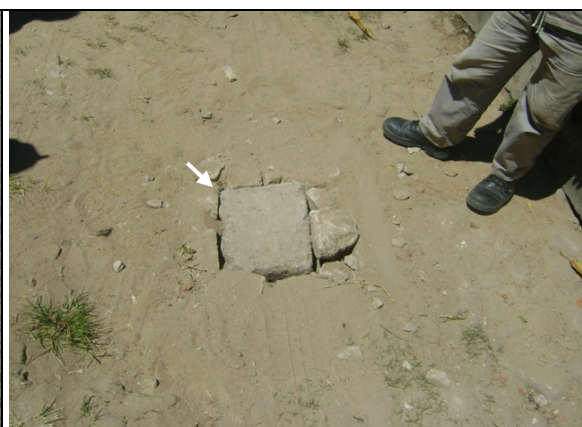
Foto 29 – Registro de descarga com caixa de proteção danificada, localizado na Rua Clínio Memória 3 de Maio.
