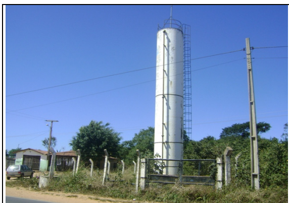
Foto 11 – Torre de equilíbrio em operação.
