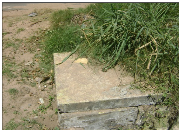
Foto 32 – Registro de descarga localizado na Rua Rodovia José Maria Melo.
