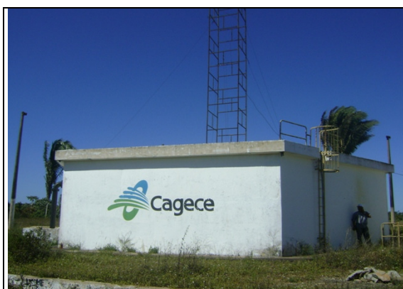
Foto 14 – RAP-12: Base improvisada de antena de rádio.
