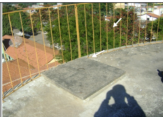
Foto 25 – REL-27: Presença de guarda-corpo na laje superior.
