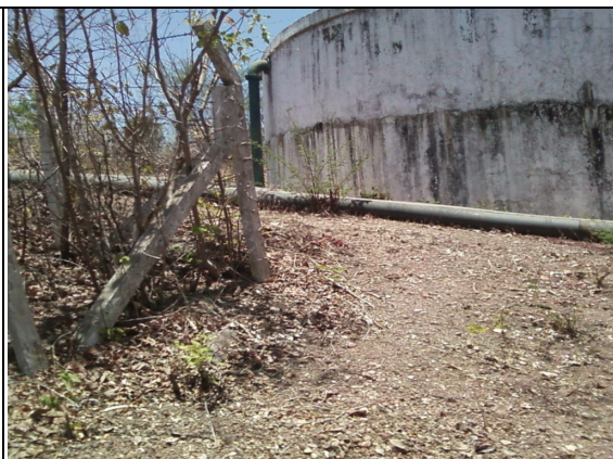
Foto 5 – RAP-02: limpeza da área em condições inadequadas.
