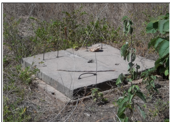
Foto 16 – Registro de descarga localizada na Estrada para Breguedorff.
