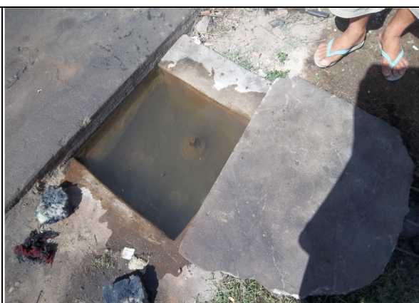
Foto 17 – Registro de manobra localizada na Rua Antonio Cristino Menezes, em frente ao lava jato Esponjão – Centro, caixa de proteção com água.
