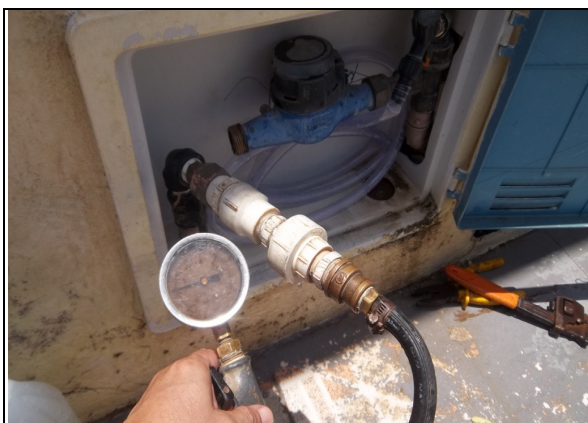
Foto 27 – RDA: medição de pressão no endereço Rua Alferes Raimundo Leopoldo - Centro.
