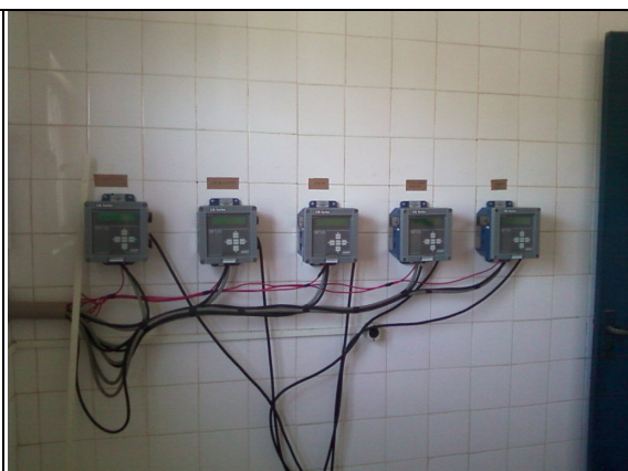
Foto 13 – AAT: equipamentos para registro da medição do volume de água.
