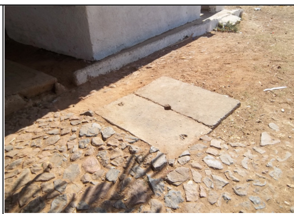
Foto 19 – Registro de descarga localizada na Rua São Miguel, 11 (FNS) – São Miguel.
