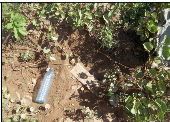
Foto 21 – Registro de descarga localizada na Vila São Francisco – Alto São José, sem caixa de proteção.
