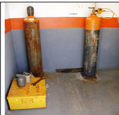
Foto 14 – Kit de emergência e cilindros de cloro
