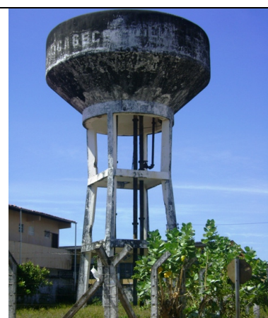
Foto 29 – Vista do REL-01
