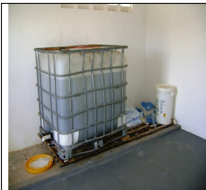
Foto 13 – Armazenamento de produtos químicos
