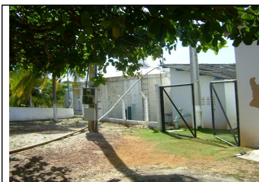
Foto 6 – Vista da entrada da ETA do SAA de Paracuru
