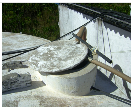
Foto 28 – RAP-01: tampa de inspeção aberta.
