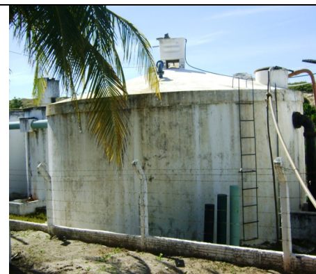
Foto 25 – Vistas do RAP-01
