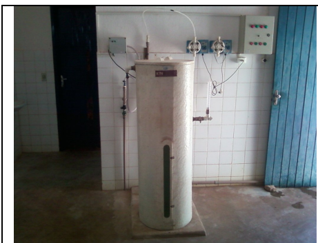
Foto 18 – Sistema de fluoretação paralisado.
