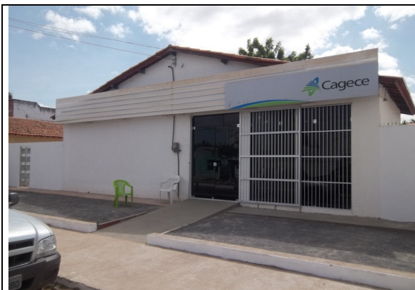
Foto 67 – Vista externa da entrada principal do escritório/atendimento do SAA de Moraujo.
