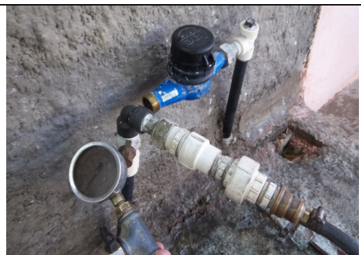
Foto 63 – RDA: medição de pressão no endereço Avenida Assembléia de Deus, 80.
