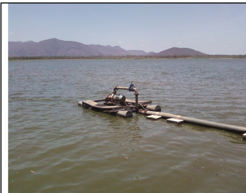
Foto 1 – Captação: 1 (um) flutuante – Açude Várzea da Volta.
