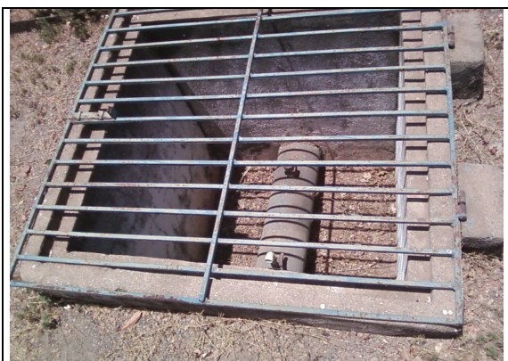
Foto 49 – Estação pitométrica na saída do REL-01.
