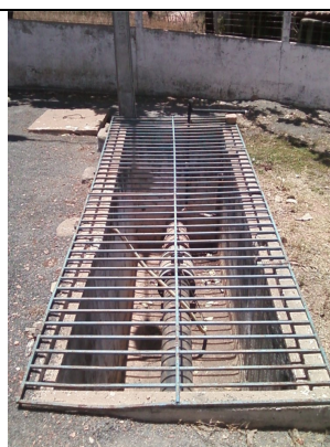
Foto 46 – Macromedidor woltman na saída do REL-01.
