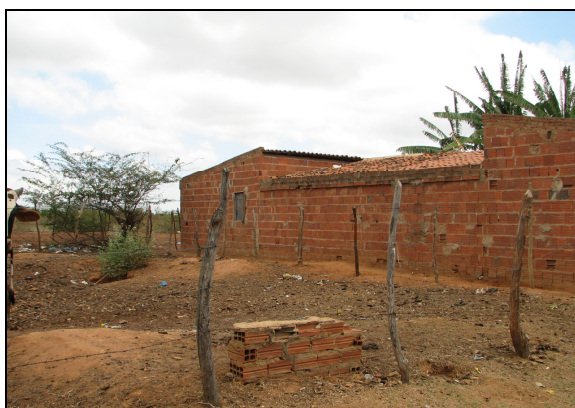
Foto 3 – Área do reservatório da Betolândia.
