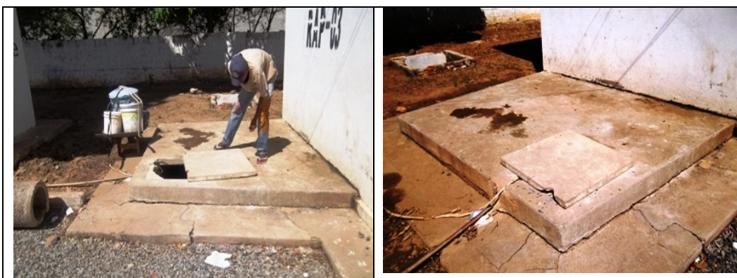
Fotos 42 e 43 – Vistas do RAP-03
