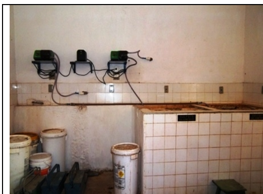
Fotos 18 e 19 – Tanques dosadores e sistema de fluoretação
