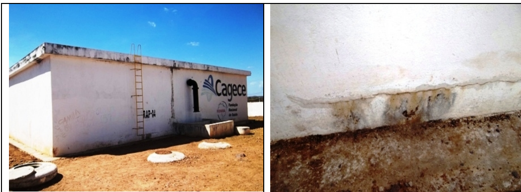
Fotos 44 e 45 – Vistas do RAP-04
