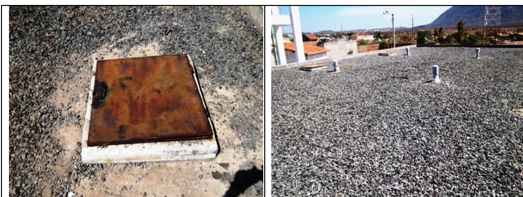
Fotos 46 e 47 – Vistas superiores do RAP-04
