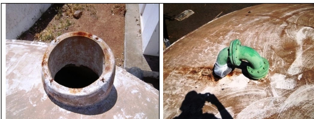
Fotos 40 e 41 – Vistas superiores do RAP-02
