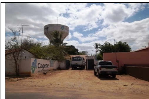
Foto 6 – Vista da entrada da ETA do SAA de Massapê
