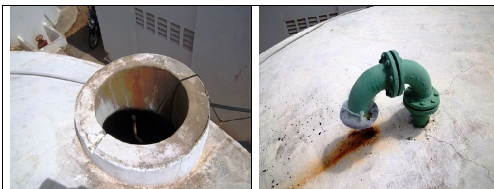
Fotos 37 e 38 – Vistas superiores do RAP-01
