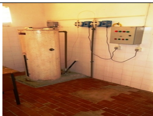
Fotos 18 e 19 – Tanques dosadores e sistema de fluoretação
