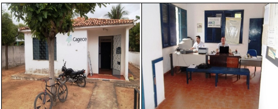
Fotos 51 e 52 – Vistas externa e interna do Escritório.
