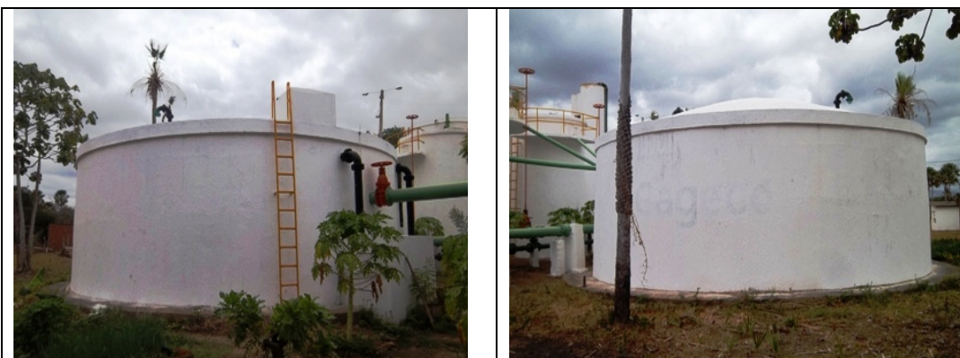
Fotos 32 e 33 – Vistas do RAP-01.
