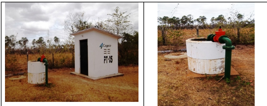
Fotos 2 e 3 – Vistas das instalações do PT-5.
