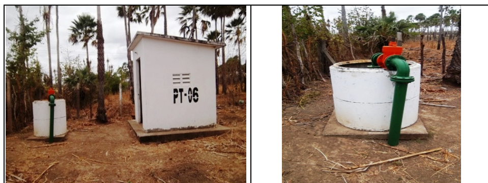
Fotos 5 e 6 – Vistas das instalações do PT-6.
