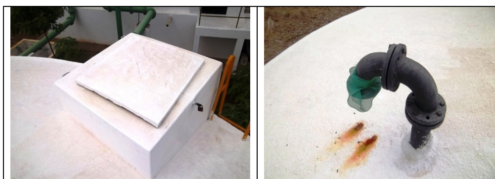
Fotos 34 e 35 – Vistas superiores do RAP-01
