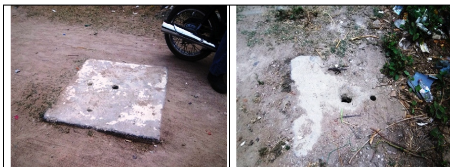
Fotos 49 e 50 – Registros de descarga nas Ruas Lucineide de Oliveira e Vigário Theotimo.
