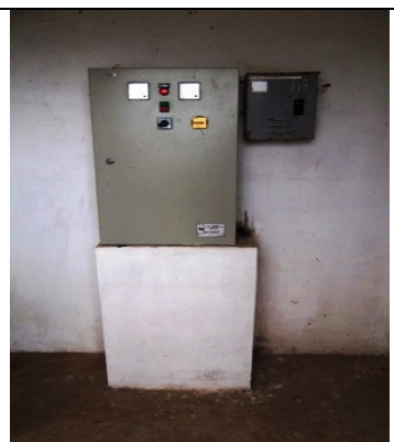
Fotos 26 e 27 – Quadros de comando das elevatórias dos poços
