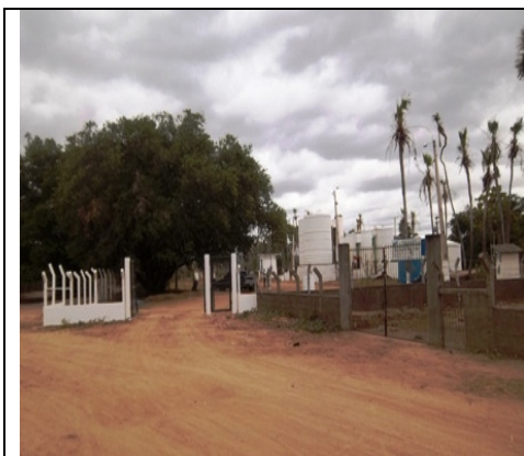
Foto 8 – Vista da entrada da ETA
