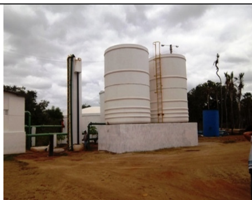
Foto 9 – Decantadores em implantação
