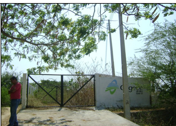
Foto 30 – Nova casa do quadro de comando da EECS-01 devidamente cercada e identificada.
