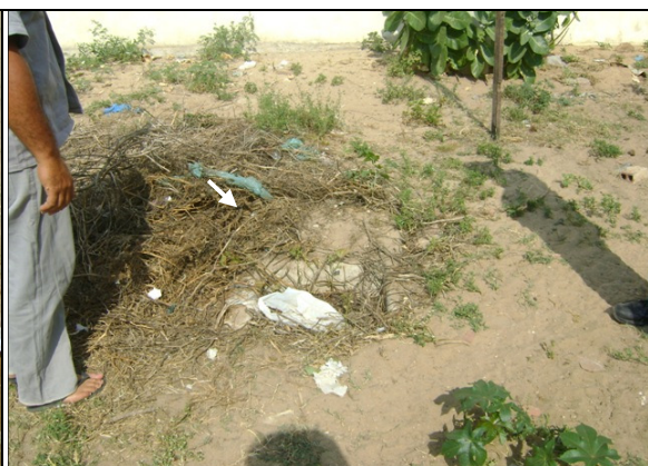
Foto 50 – Registro de descarga localizado na Rua Luís Estevan, sem de tampa.
