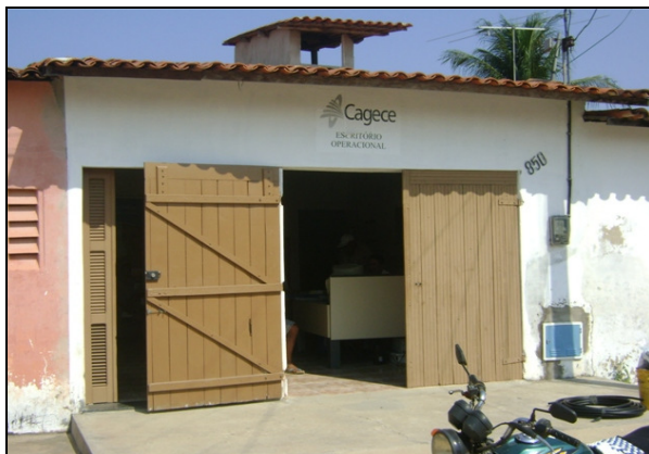
Foto 55 Vista externa do escritório/loja de atendimento ao usuário.
