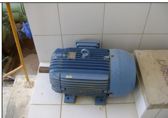
Foto 32 – EEAT-01: Motor do conjunto moto-bomba reserva desinstalado .
