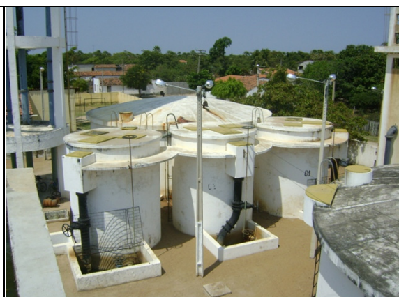
Foto 3 – ETA: área apresentando bom estado de conservação e limpeza.
