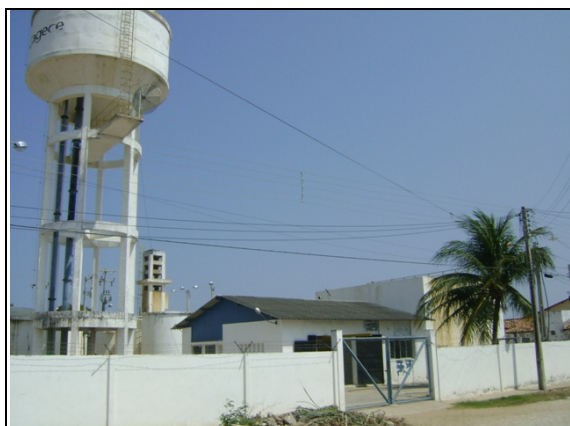
Foto 2 – Vista da ETA.
