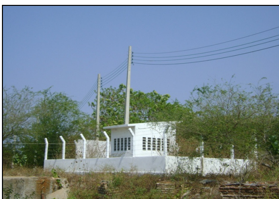
Foto 29 – Nova casa do quadro de comando da EECS-01.
