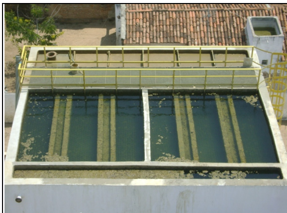
Foto 4 – Floco-decantador.
