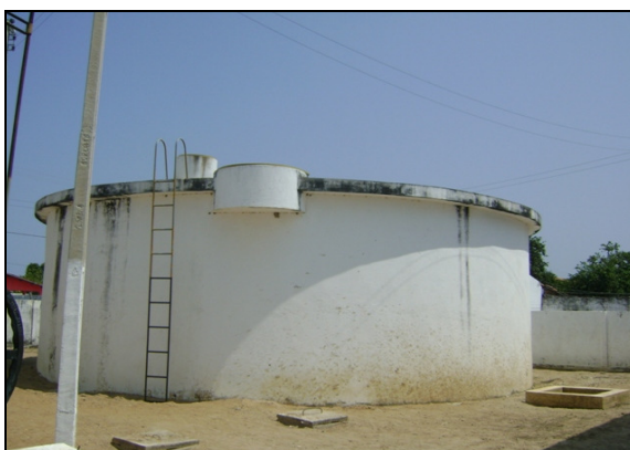
Foto 41 – RAP-02: Sem identificação.
