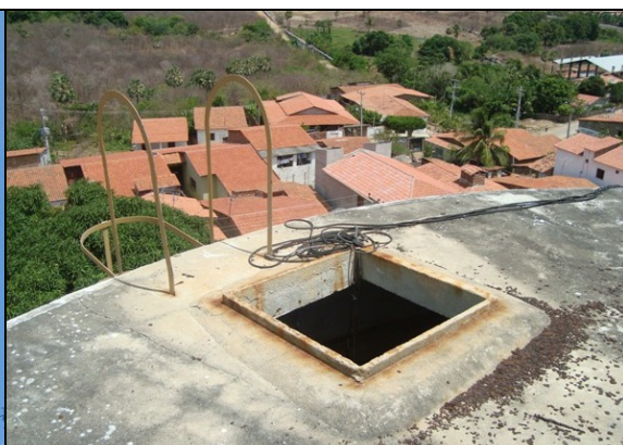
Foto 33 – Inspeção do REL-01.
