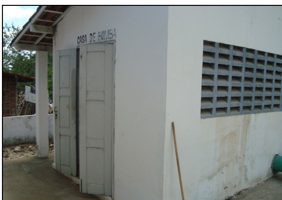
Foto 27 – Casa de comando da EEAT-01.
