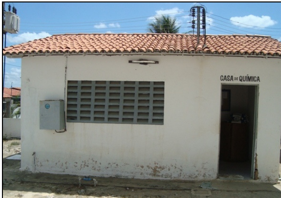
Foto 11 – Casa de química.
