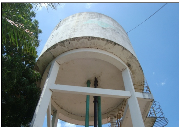
Foto 32 – Vista do REL-01.
