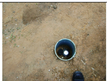
Foto 52 – Macromedidor na saída do PT-03
