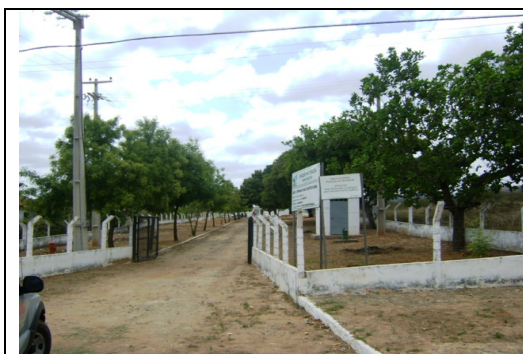
Foto 12 – Vista da entrada da ETA do SAA de Missão Velha
