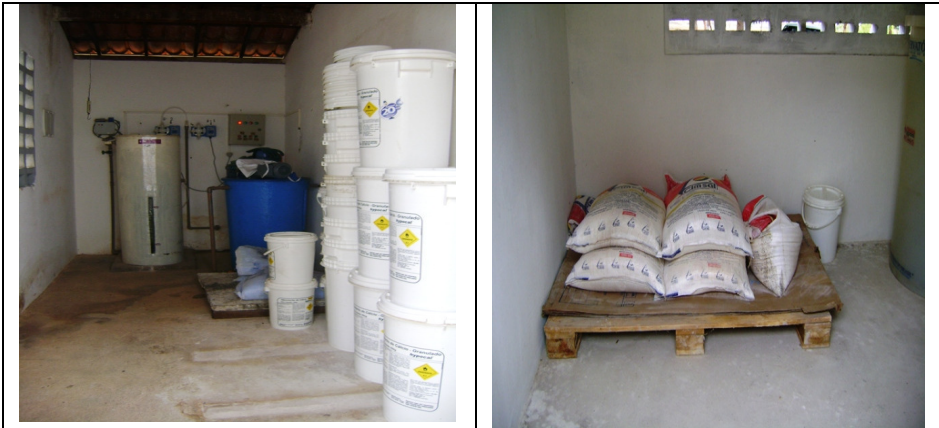
Fotos 19 e 20 – Armazenamento adequado de produtos químicos
