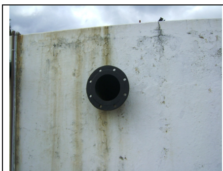
Foto 40 – RAP-01: Tubulação lateral aberta
