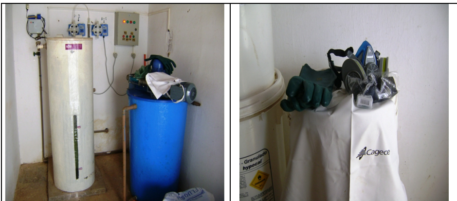
Foto 23 – Sistema de fluoretação
