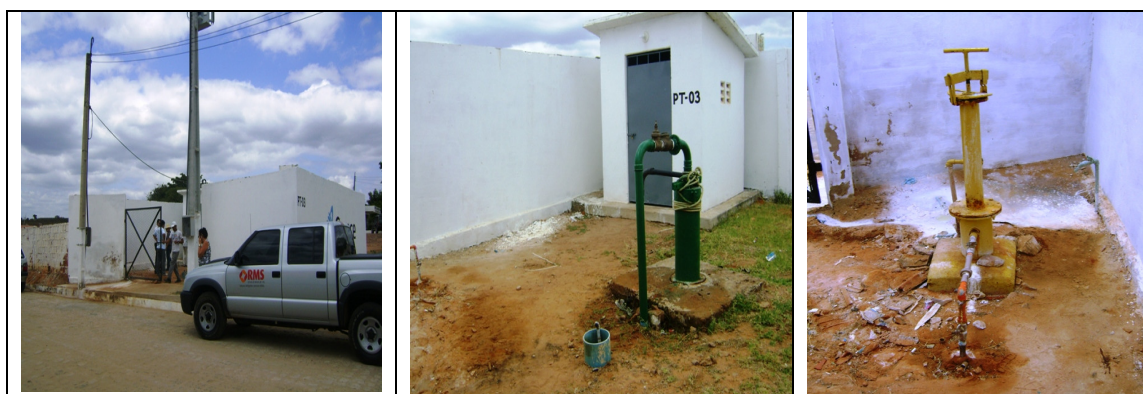
Fotos 9 a 11 – Vistas da área da captação destacando o PT-03 e sistema de cloração
