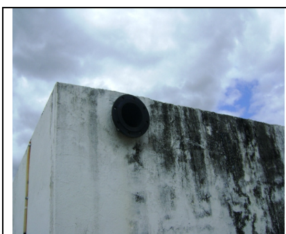
Foto 44 – RAP-02: Tubulação lateral aberta
