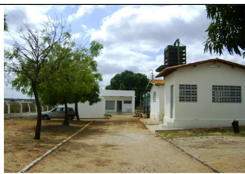
Foto 13 – Área interna da ETA
