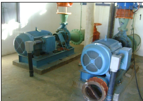
Foto 45 – Elevatórias EEAB-01 e EEAT-03.
