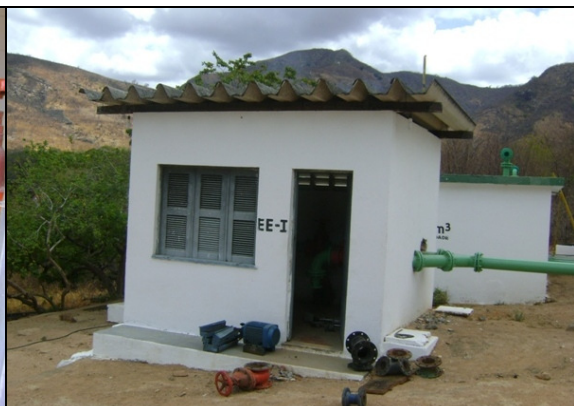
Foto 50 – Casa de comando da elevatória EEAT-01.
