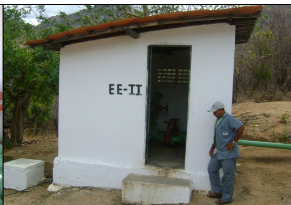
Foto 54 – Casa de comando da elevatória EEAT-02.
