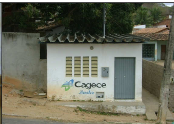
Foto 58 – Casa de comando da elevatória EERD-01.
