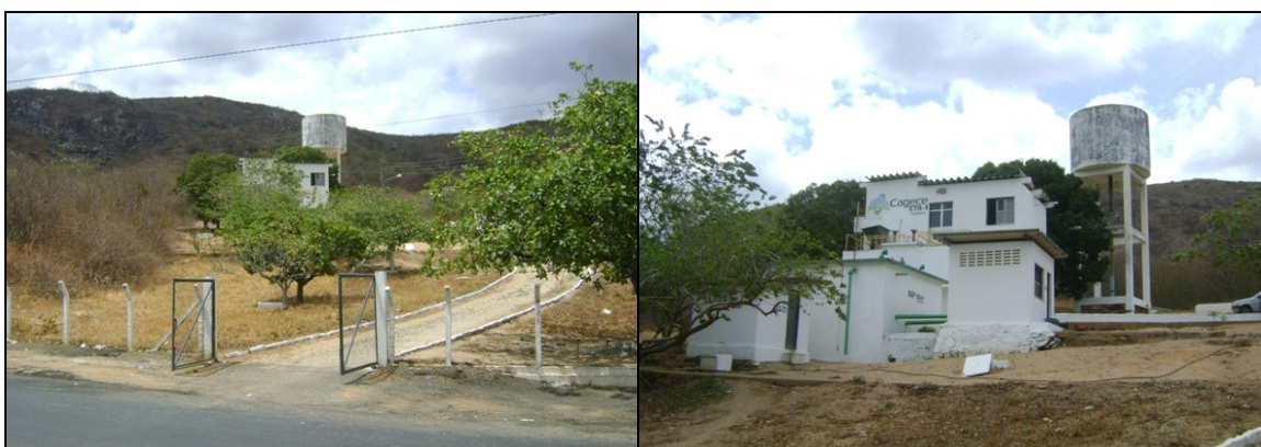
Fotos 4 e 5 – Vistas da ETA-01.
