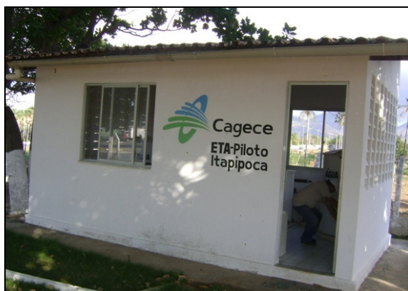
Foto 33 – Vista externa da ETA Piloto.
