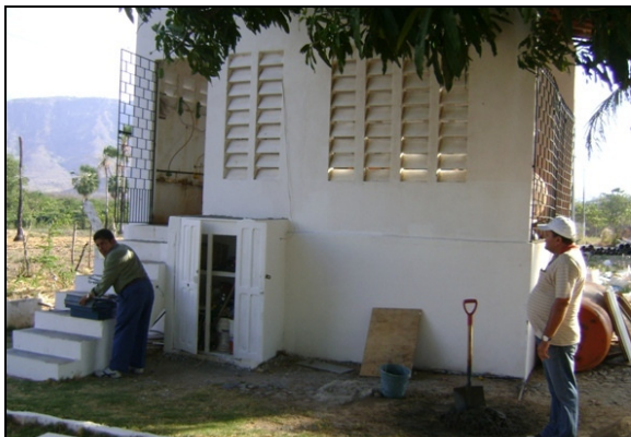
Foto 29 – Casa de cloro.
