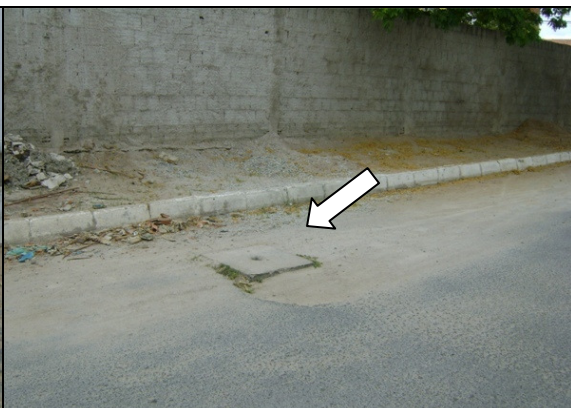
Foto 83 – Registro de descarga na Rua Frei Cassiano, São Sebastião.
