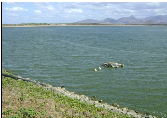
Foto 2 – Tomada d'água do Açude Poço Verde.
