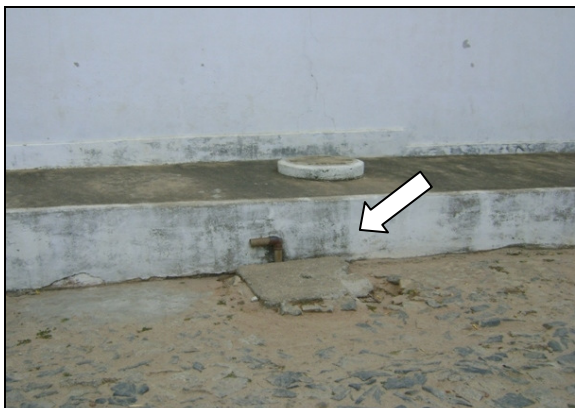
Foto 82 – Registro de descarga na Rua Terezinha de Lavour, Ladeira.
