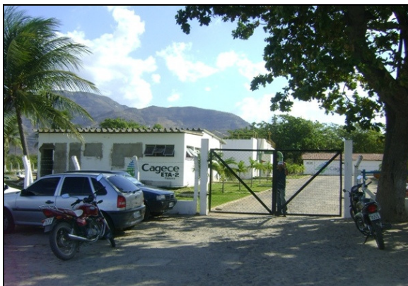
Foto 16 – Vista da ETA-02.
