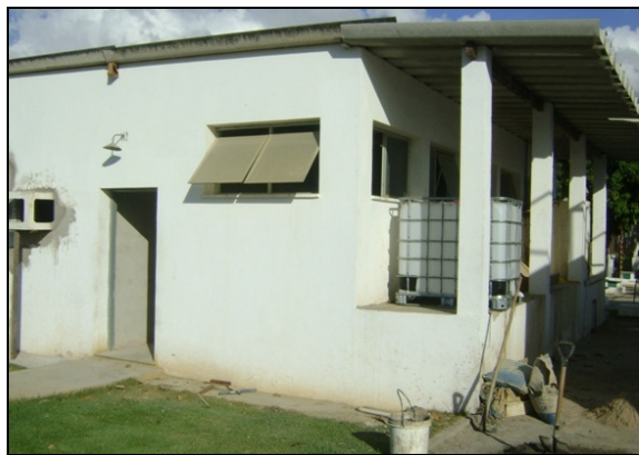
Foto 25 – Vista da casa de química.
