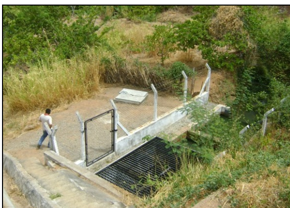
Foto 3 – Tomada d'água do Açude Quandu.
