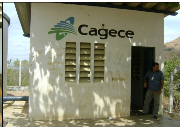
Foto 67 – Casa de comando da elevatória EERD-04.
