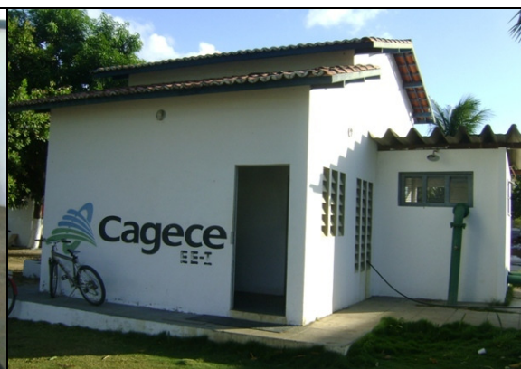
Foto 46 – Casa de comando das elevatórias EEAB-01 e EEAT-03.
