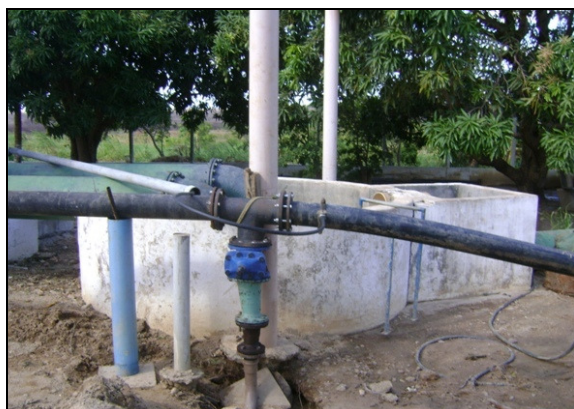
Foto 72 – Vista do PRE-01.
