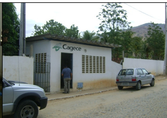
Foto 64 – Casa de comando da elevatória EERD-03.
