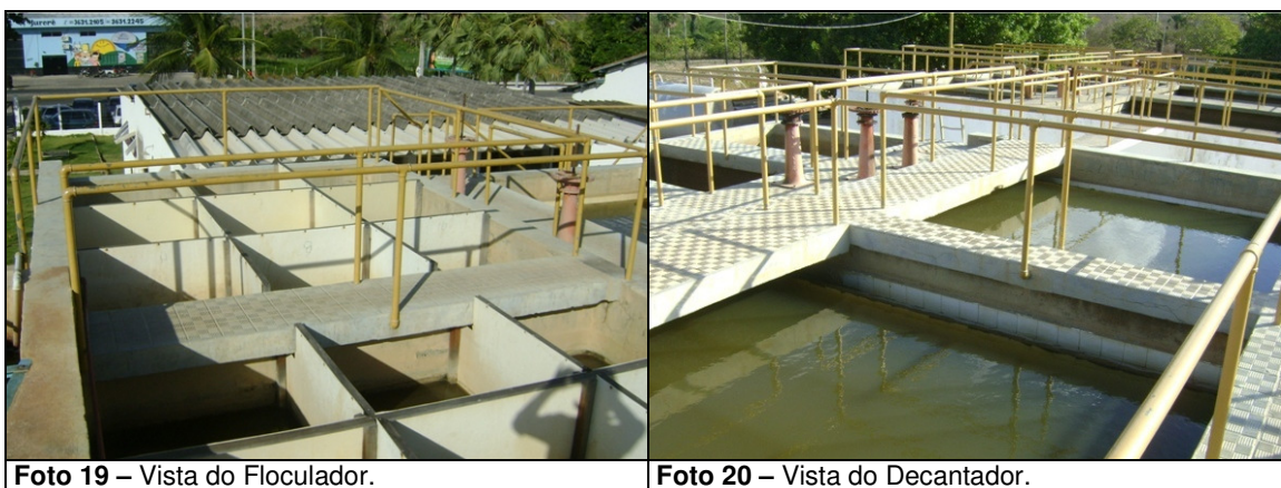
Foto 19 – Vista do Floculador.
