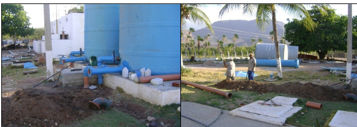
Fotos 23 e 24 – Vistas dos filtros em instalação.
