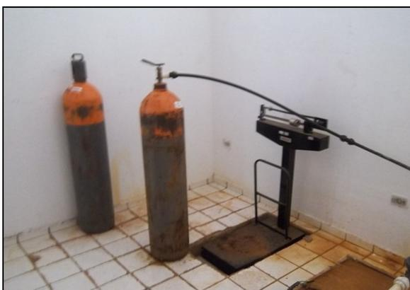
Foto 12 – Cilindros de cloro gasoso e balança.
