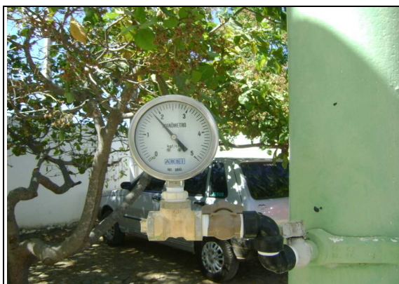
Foto 59 – REL-01: manômetro para medição de nível.
