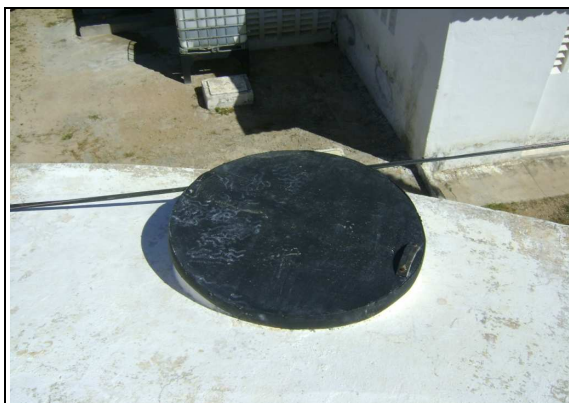
Foto 55 – RAP-02: tampa de inspeção.
