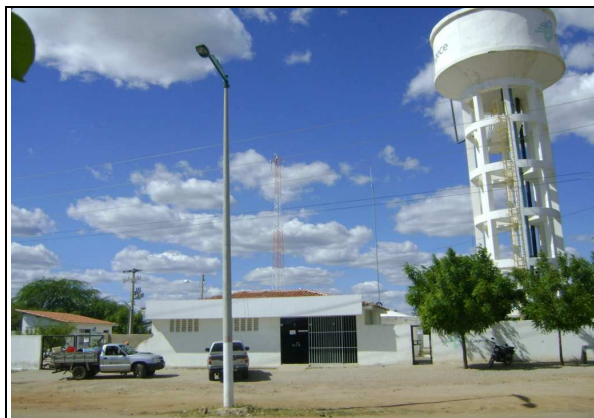
Foto 85 – Vista externa do escritório/loja de atendimento/almoxarifado.
