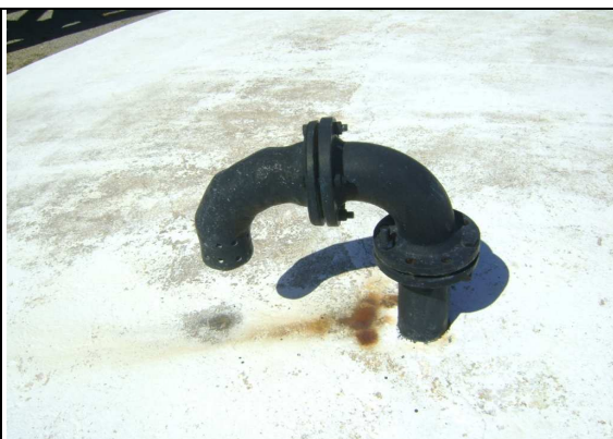
Foto 56 – RAP-02: tubulação de ventilação.
