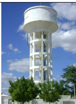
Foto 43 – REL-01 (ETA): vista geral.
