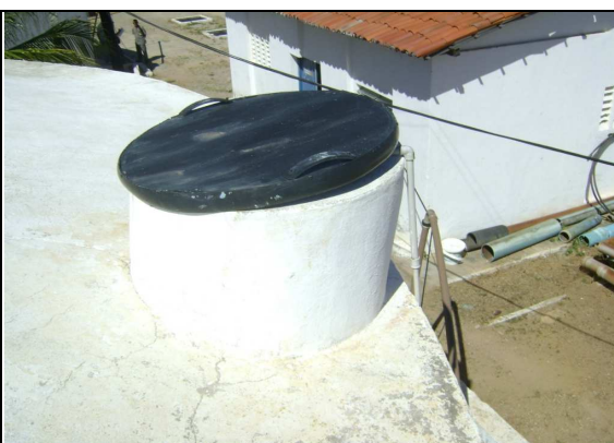
Foto 58 – RAP-03: tampa de inspeção.
