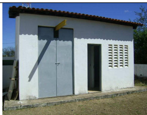
Foto 2 – Fachada principal da estação elevatória do floco-decantador.
