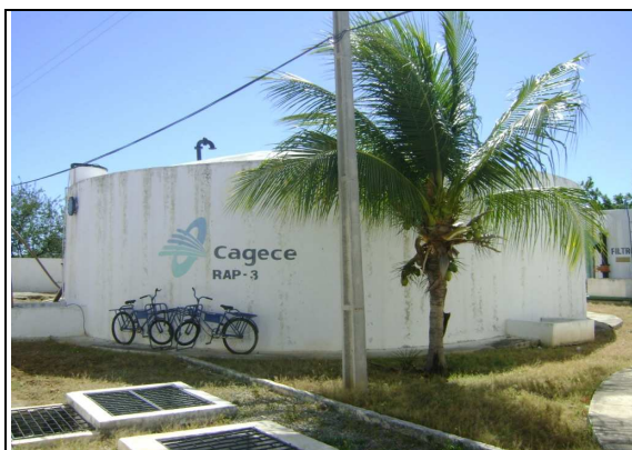
Foto 42 – RAP-03 (ETA): vista geral.
