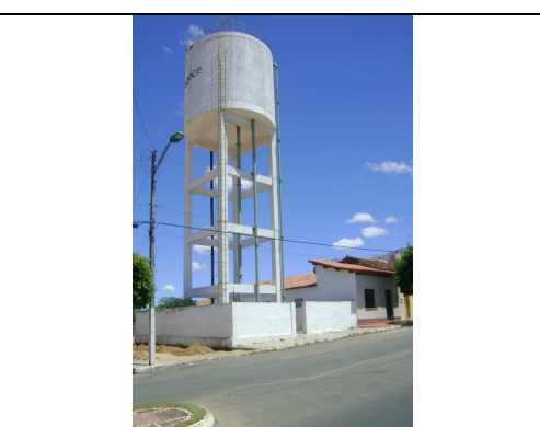
Foto 4 – Vista geral do REL-02, funcionando como caixa de passagem.
