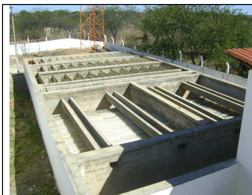
Foto 1 – Vista geral do floco-decantador: em construção.
