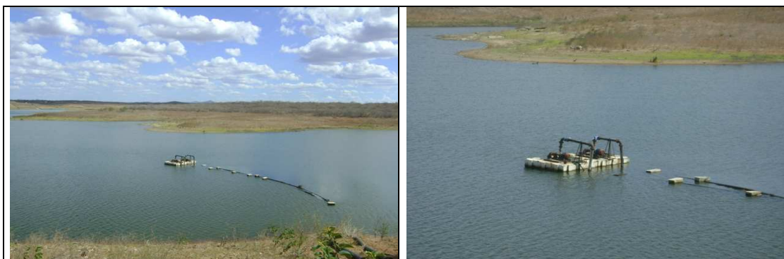
Foto 1 – Captação Principal: Açude Jerimum. Foto 2 – Captação Principal: Flutuante.
