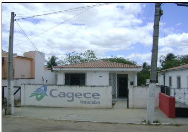
Foto 61 – Vista externa do escritório/loja de atendimento ao usuário.
