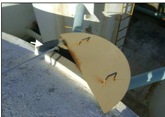
Foto 39 – RAP-01: Calha coletora apresentando tampa sem fechamento hermético.
