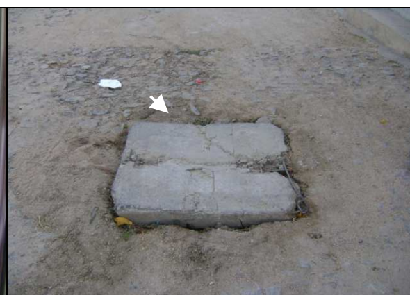
Foto 53 – Registro de descarga localizada na Rua 7 de Setembro, apresentando tampa danificada.
