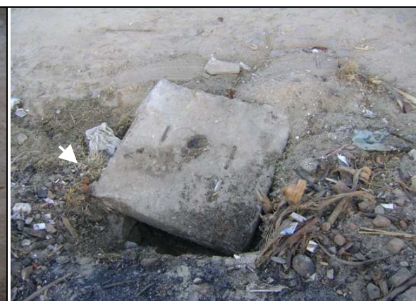
Foto 55 – Registro de descarga localizada na Rua Luis da Mota Melo: sem caixa de proteção.
