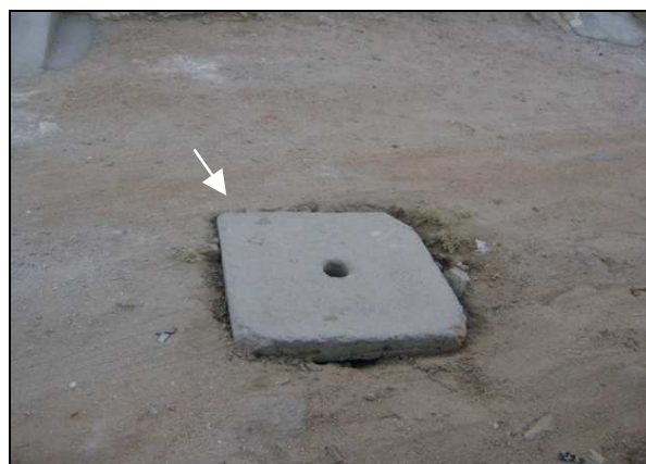
Foto 54 – Registro de descarga localizada na Rua Euriva Negreiros.
