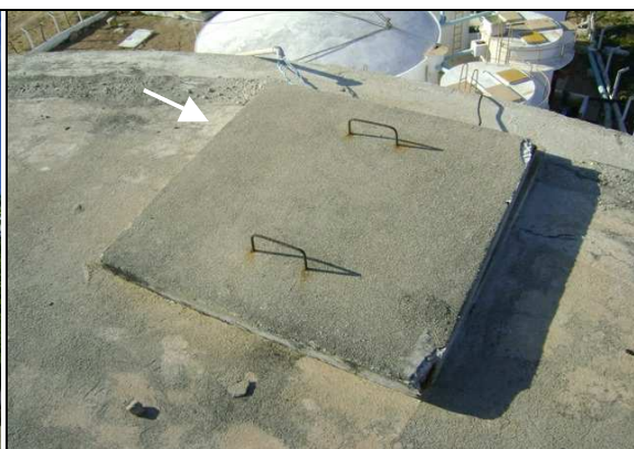
Foto 42 – REL-01: Existência de tampa de inspeção adequada.
