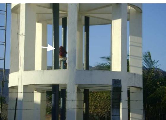
Foto 50 – REL-01: Crianças descendo pela tubulação de saída do reservatório.
